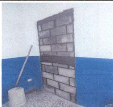
Foto 3: Se termino de levantar la pared de la direccion
