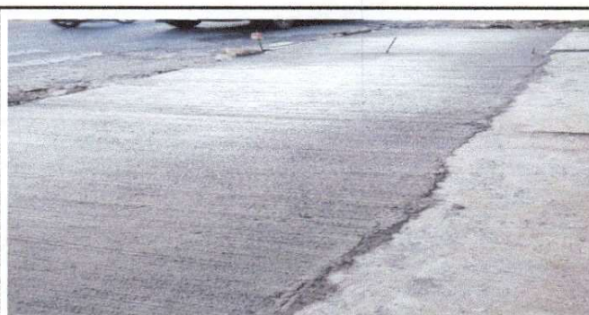
Foto 6: Se termino de fundir la baqueta de la entrada principal.
