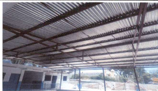
Foto 2: Se termino de colocar la luz del techo
