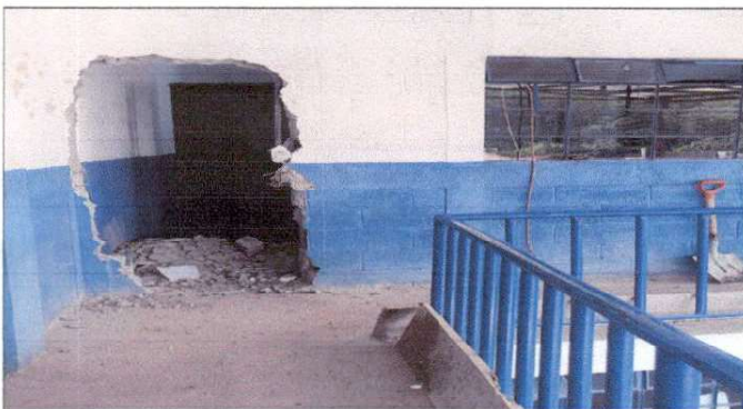
Foto 3: Se comienza con la abertura del espacio donde se colocara la nueva puerta de la direccion de la jornada de la tarde.
