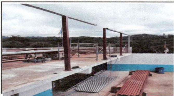
Foto1: Se comienza con la base del techo del patio
