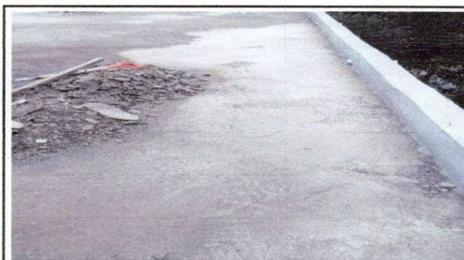
Foto 4: Se empieza a limpiar el area de la loza donde se va a colocar el impermeabilizante del area del grado de segundo y tyercero basico.
