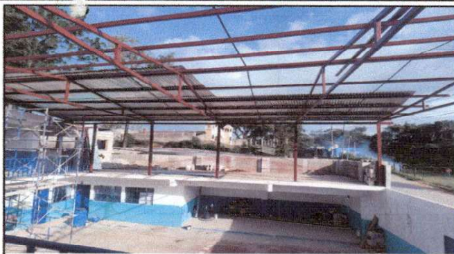
Foto 2: Se empieza con la estructura del techo y colocación de la lámina
