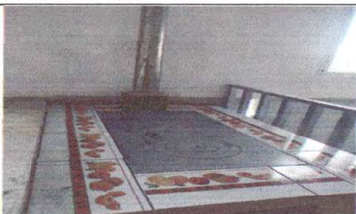
Foto 3: colocación de azulejo finalizado cocina rural de leña.
