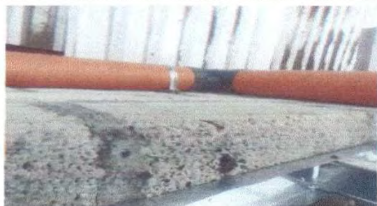
Foto 1: TUBO CAÍDA PLUVIAL ÁREA DE COCINA.
