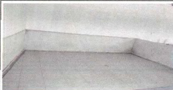
Foto1: sustitución de torta de concreto por piso finalizada.
