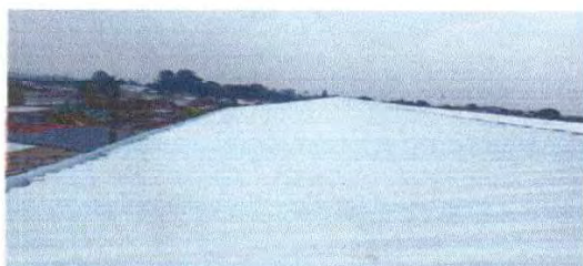
Foto 3: VISTA DE LA PARTE DE ARRIBA ESTRUCTURA DE TECHO COCINA FINALIZADA.
