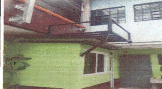
Foto 2: estructura para base de soporte tinaco.
