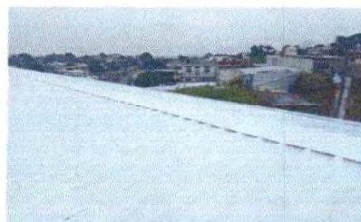
Foto 4: VISTA DE LA PARTE DE ARRIBA ESTRUCTURA DE TECHO ÁREA DE COCINA FINALIZADA.
