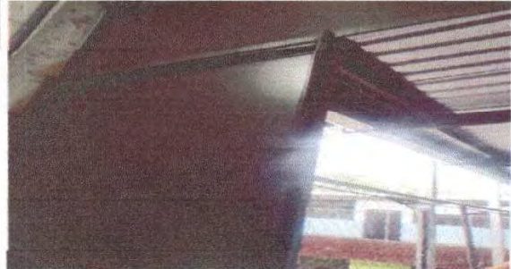
Foto 1: puerta de bodega finalizada parte de arriba pasadores
