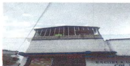
Foto 2: FINALIZACIÓN ESTRUCTURA DE TECHO ÁREA DE COCINA VISTA FRONTAL
