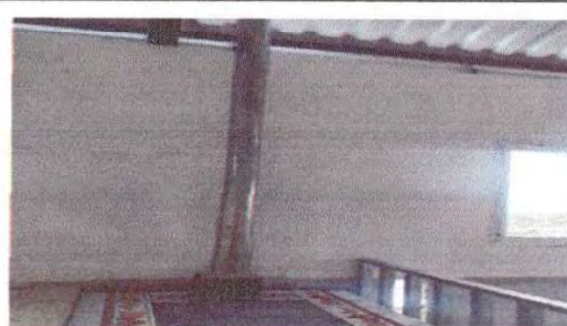
Foto 2: chimenea de cocina rural de leña finalizada.
