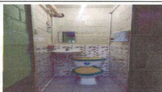
Foto 4: remozamiento sanitario instalacion de lavamanos, sanitario con tuberia.
