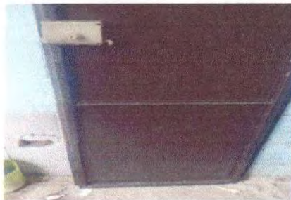
Foto 3: puerta de bodega finalizada chapa.
