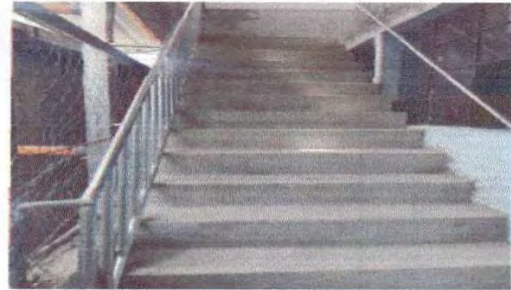
Foto 2: Gradas finalizadas accesococina.
