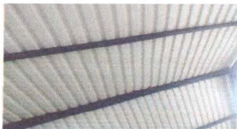
Foto1: ÁREA DE TECHO FINALIZADA VISTA INTERIOR
