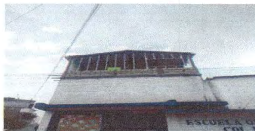
Foto 6: VISTA FRONTAL FINALIZADA ÁREA DE COCINA ESTRUCTURA DE TECHO.
