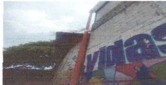
Foto 4: COLOCANDO SUBTERRANEO EL TUBO PARA PROTECCIÓN.
