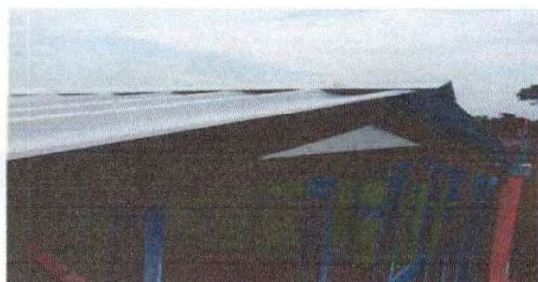
Foto 5: Vista lateral estructura de techo finalizada área de cocina.
