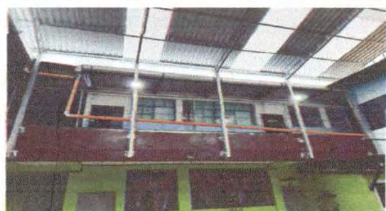
Foto 3: Remozamiento iluminación patio finalizado.
