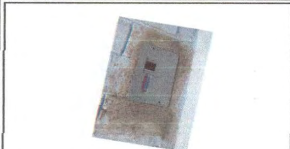
Foto1: Caja y flípones principales nueva instalación finalizada.
