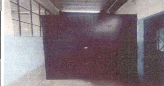
Foto 4: puerta de bodega finalizada.
