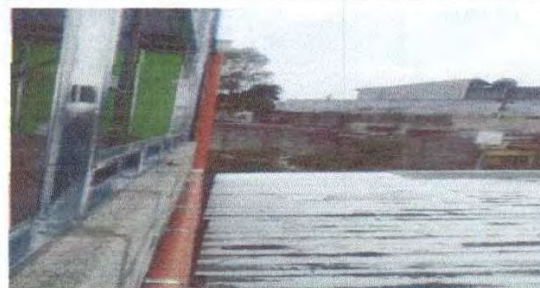
Foto 2: COLOCACIÓN DE TUBO CAÍDA PLUVIAL ÁREA DE COCINA COLOCACIÓN DE ABRAZADERAS.
