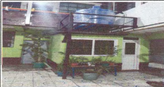
Foto 3: estructura base de soporte para tinaco.
