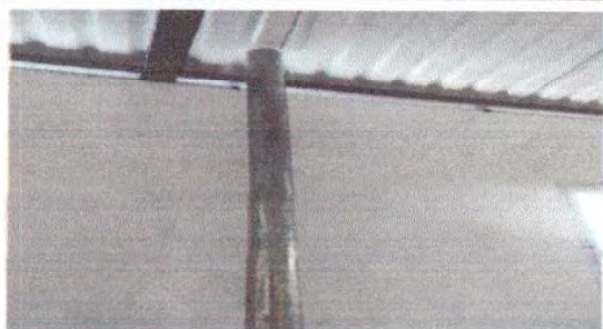
Foto 1: Chimenea cocina rural de leña finalizada.
