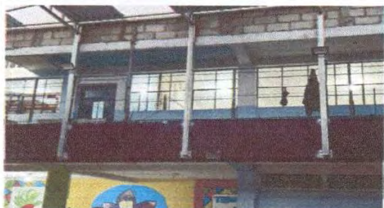
Foto 1: Remozamiento iluminación patio finalizado.
