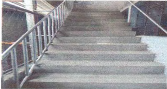
Foto 1: Gradas finalizadas accesococina.
