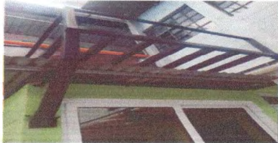
Foto 1: estructura para base de soporte tinaco.
