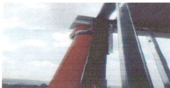
Foto 3: UNIFICANDO EL TUBO DE CAÍDA PLUVIAL ÁREA DE COCINA.
