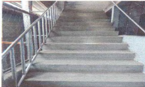
Foto 3: Gradas finalizadas accesococina.
