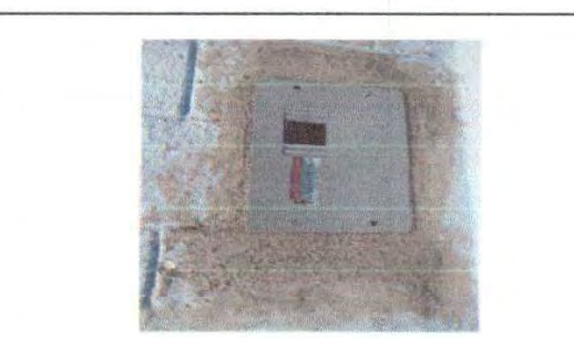
Foto 4: Caja y flípones principales nueva instalación finalizada.
