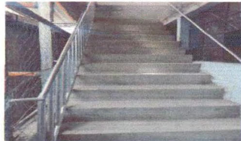
Foto 4: Gradas finalizadas accesococina.
