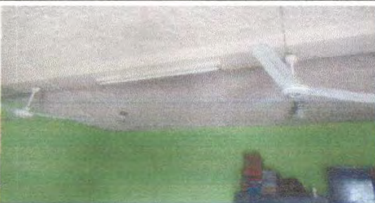
Foto 3: pintura finalizada techo.
