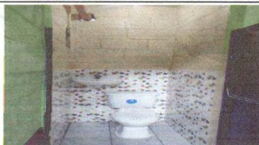
Foto 3: remozamiento sanitario azulejo, pintura piso.
