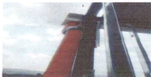
Foto 5: CONECCIÓN DE CAÍDA 1 PLUVIAL ÁREA DE COCINA.
