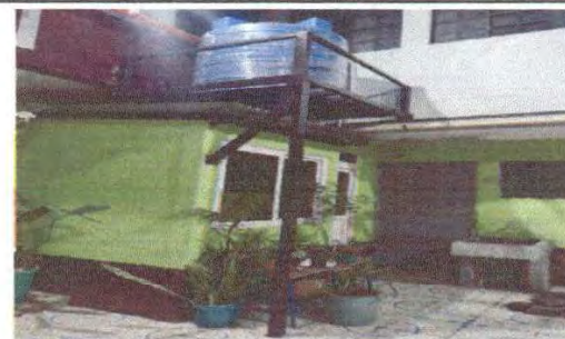
Foto 4: estructura base de soporte para tinaco.
