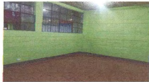
Foto 6: Pintura de paredes interior de aulas.
