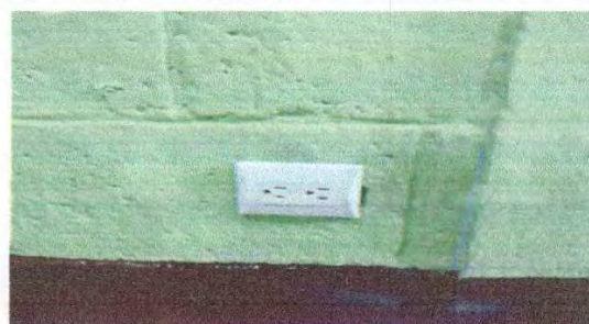
Foto 4: Instalación de dos tomacorrientes en cuatro aulas del primer nivel finalizada.
