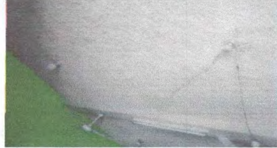
Foto 2: Pintura finalizada techo.
