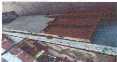
Foto 1: Desmontaje de puerta de bodega segundo nivel,
