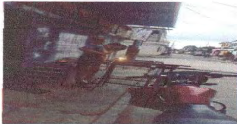
Foto1: Realizando estructura para base de soporte tinaco.
