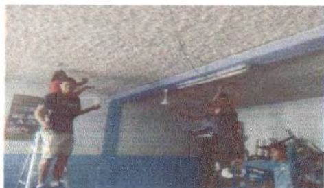
Foto 1: LIMPIANDO, RASPADO E INICIO DE PINTADO AREA DE TECHO AULA.
