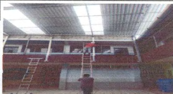
Foto 2: colocación de lamparas tipo reflectores led.
