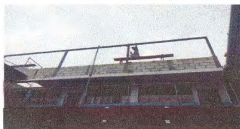
Foto 3: ESTRUCTURA DE TECHO COLOCACIÓN DE TUBO
