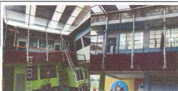
Foto 6: cuatro lamparas tipo reflectores led están siendo instalados para alumbrar el patio primer nivel.
