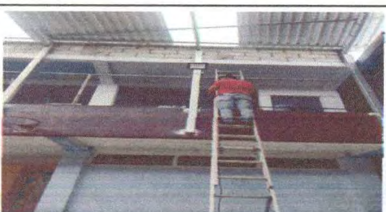
Foto 3: conexión de lamparas tipo reflectores led.
