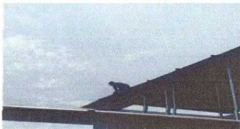
Foto 1: DESMONTAJE ÁREA DE COCINA.
