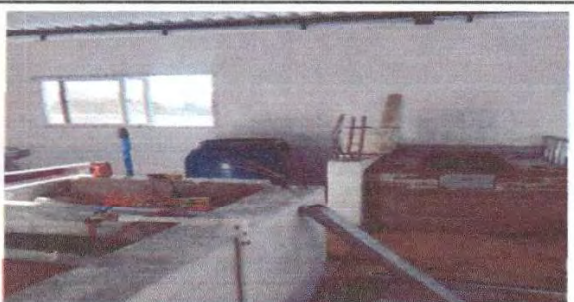
Foto 5: preparación para el repello de la cocina rural de leña.
