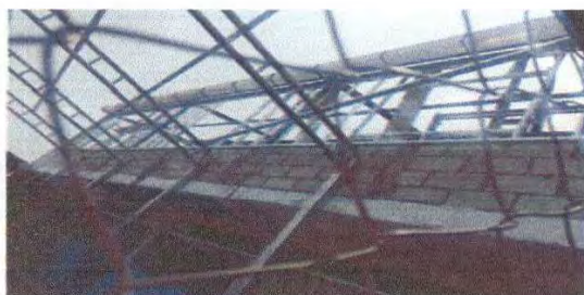
Foto 5: FABRICACIÓN Y COLOCACIÓN DE CANALES METÁLICOS.
