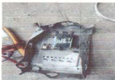
Foto 3: DESMONTAJE DE TABLERO ANTIGUO DESCONTINUADO.
