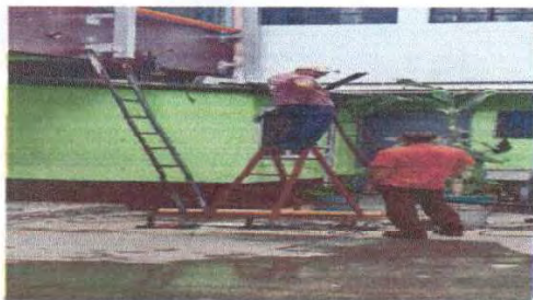
Foto 3: Ensamblaje de estructura base de soporte para tinaco,
