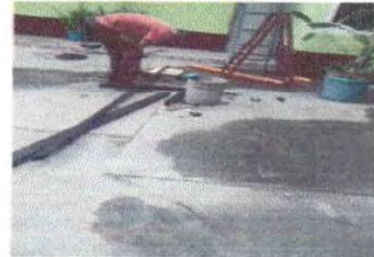
Foto 2: Soldadura de estructrua para base de soporte tinaco.
