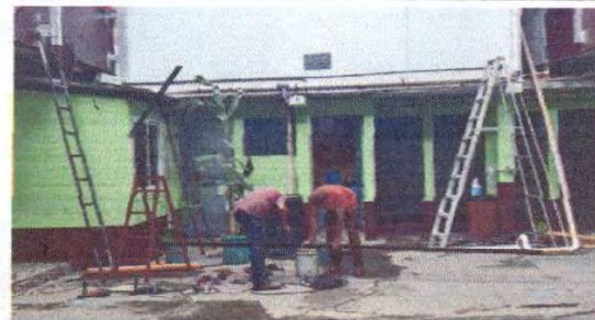
Foto 4: Ensamblaje de estructura base de soporte para tinaco.
