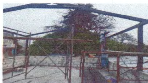
Foto 4: SOLDADURA DE SOPORTE ESTRUCTURA.
