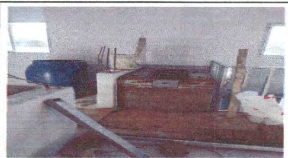
Foto 4: colocación de azulejo parte de arriba.
