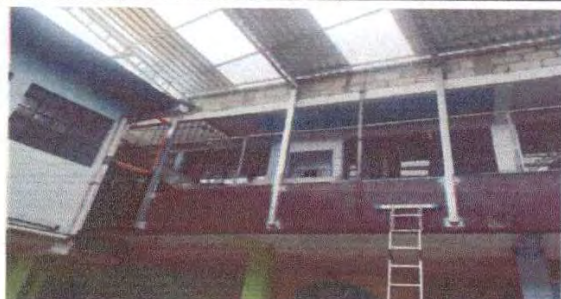
Foto 1: claveado y entubado electrico para iluminación área de patio primer nivel.
