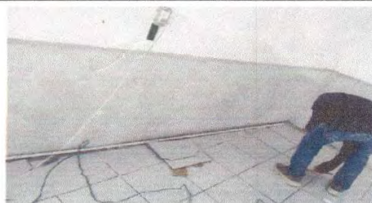
Foto 4: sustitución de torta de concreto por piso area de cocina
