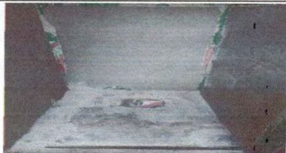
Foto 1: remozamiento de sanitario .
