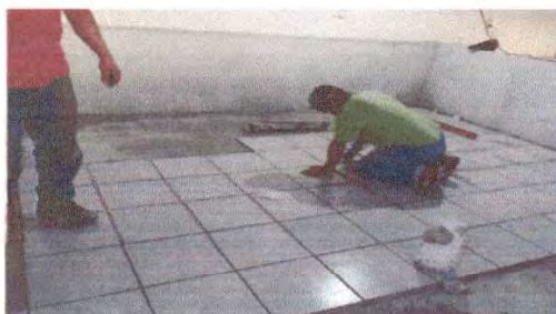
Foto 3: sustitución de torta de concreto por piso area de cocina
