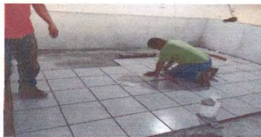
Foto 2: sustitución de torta de concreto por piso area de cocina
