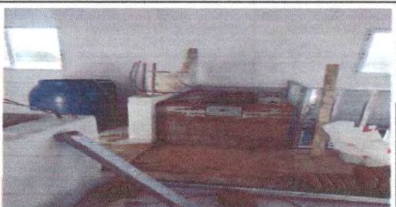
Foto 6: preparación de la chimenea de la cocina rural de leña.
