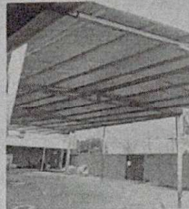
Foto 2: Instalación de canales de aguas y bajadas pluviales.
