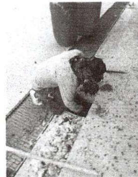
Foto 4: Perforación de agujeros para la base de estructura de techo.
