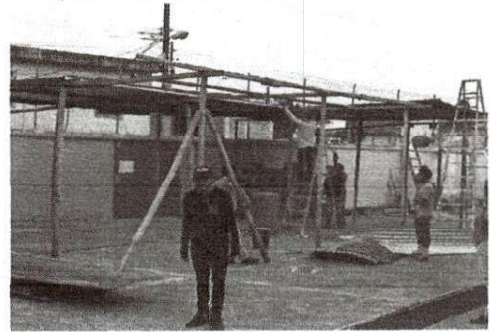
Foto 2: Retirando las laminas del techo .
