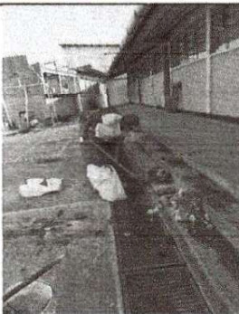
Foto 5 Fundición y sustitución de las bases para la estructura del techo.
