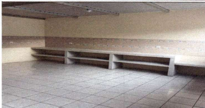
Foto 2: Repello de paredes de la cocina y azulejo
