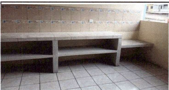
Foto 3: Colocación de piso y elaboracion de mueble de concreto
