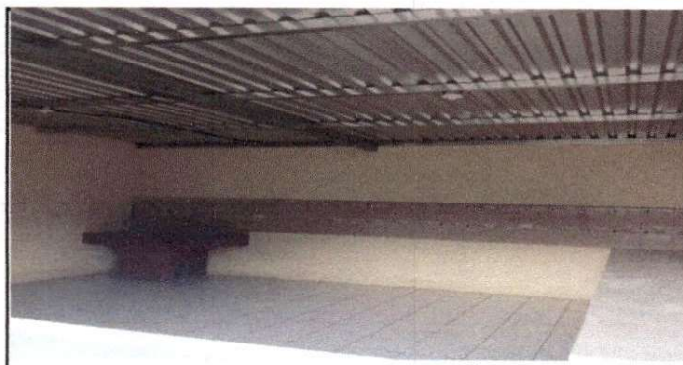
Foto 4: colocacion de piso y cisa
