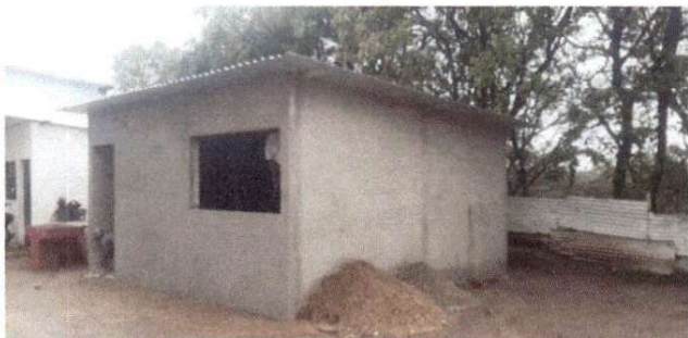
Foto 1: la base del ambiente con techo ya finalizado
