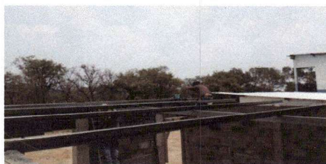
Foto 6: colocación de costaneras para colocación de láminas
