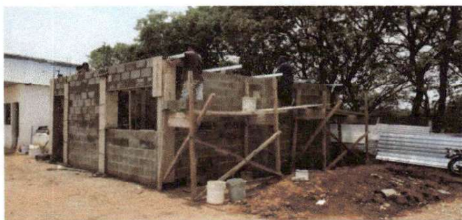
Foto 3: Ya casi formado el ambiente de 6 x 6 llegando a la altura
