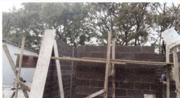
Foto 2: Llegando a la altura considerada para la colocación de costaneras
