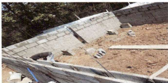
Foto 1: Elaboracion de paredes de block
