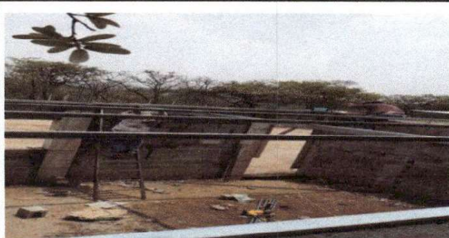
Foto 4: Colocación de costaneras y vigas para el techado
