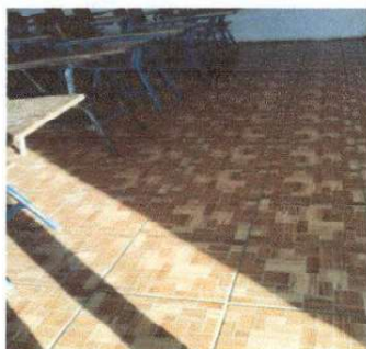
Piso nuevo instalado en aula.
