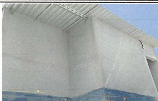
Paredes y techo intervenido en área de cocina.
