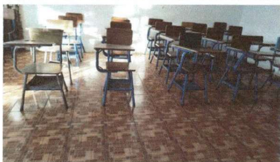
Piso nuevo instalado en aula.
