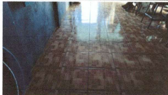
Piso nuevo instalado en aula.
