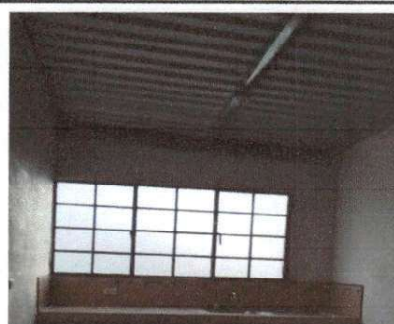
Ventanas, techo y mueble de cocina intervenida.
