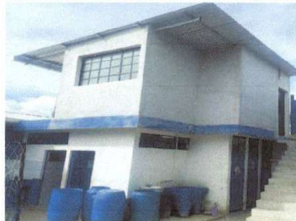
Área de cocina intervenida.
