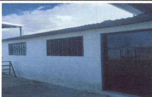
Balcones y puerta instaladas en aula.
