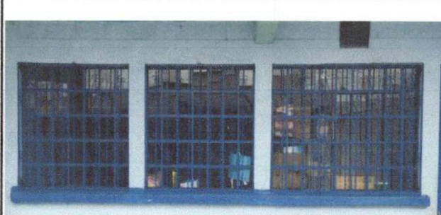
Ventanas y balcones intervenidas.
