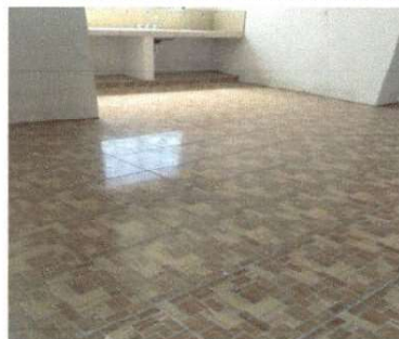
Piso intervenido área de cocina.
