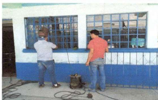
Balcones de metal instalados en aula.
