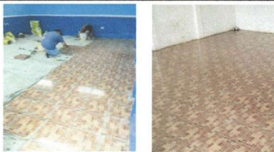
Instalación de piso cerámico en aulas.
