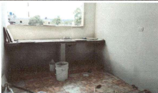
Armado, tallado de mueble, y colocación de lavatrastos en área de cocina.
