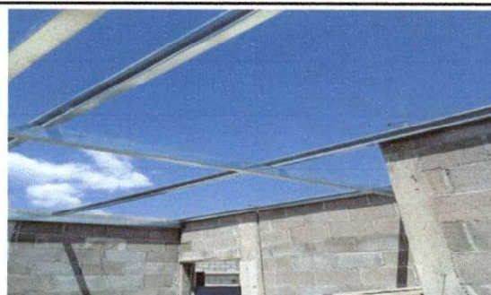
Armado de estructura metálica para colocación de lámina troquelada calibre 26
