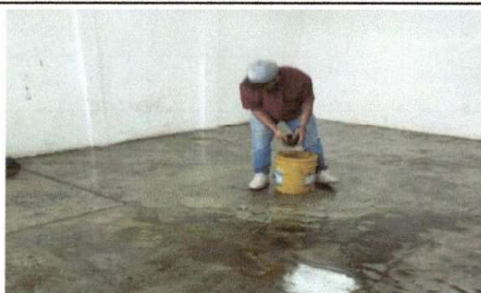
Limpieza con ácido muriático para colocación de piso cerámico en aula.
