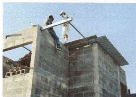
Instalación de lámina troquelada calibre 26 en techo en el área de cocina.
