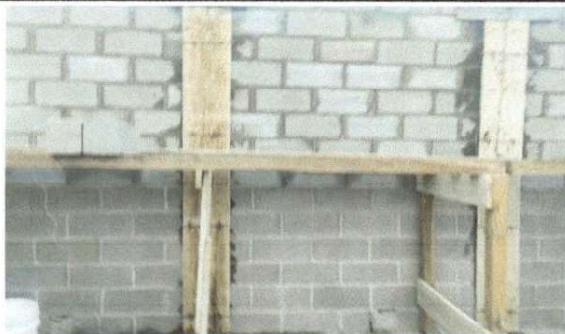
Levantado de pared de block y concreto en el área de cocina.
