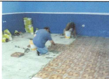
Nivelación y colocación de piso cerámico en aula.
