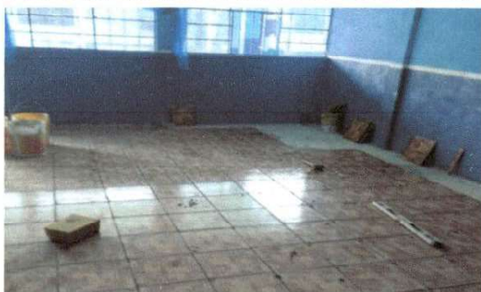
Nivelación y colocación de piso cerámico en aula.
