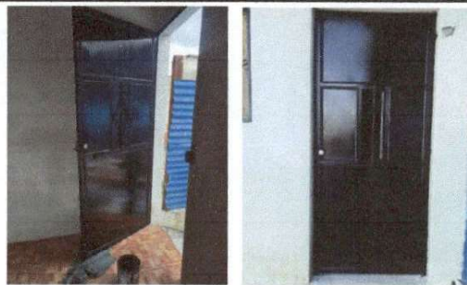
Puerta en aula y en cocina instaladas.
