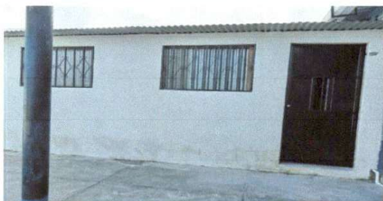
Colocación de balcones y puerta de metal en aula.
