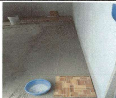
Colocación de piso en área de cocina.
