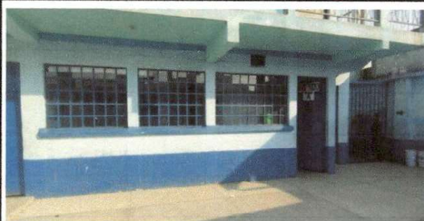
Intervención de tres balcones en aula #1
