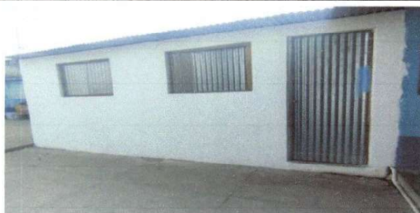
Intervención de dos balcones en aula #5
