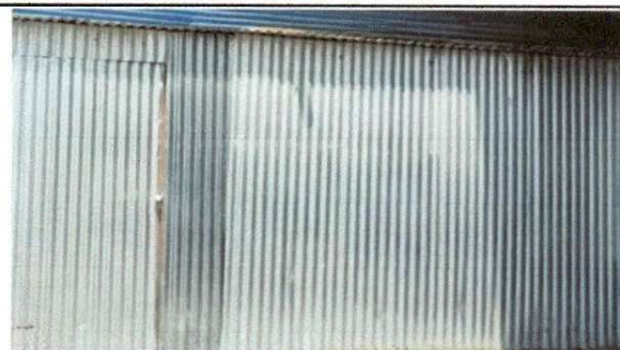
Estado actual de la cocina para intervenirla.
