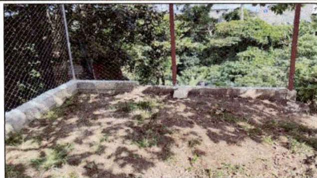
Foto 2: INSTALACIÓN TUBO DE DRENAJE
