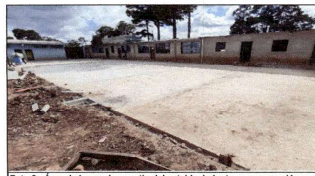
Foto 6: Área de la cancha y patio del establecimiento con reparación con torta de concreto.
