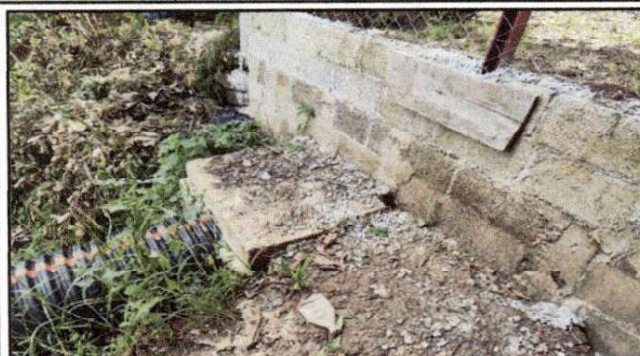
Foto 1: INSTALACIÓN TUBO DE DRENAJE
