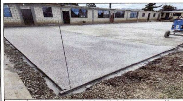
Foto 5: Área de la cancha y patio del establecimiento con reparación con torta de concreto.
