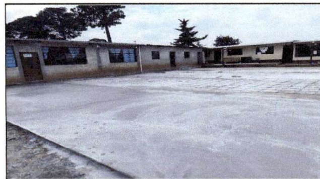
Foto 4: Área de la cancha y patio del establecimiento con reparación con torta de concreto.
