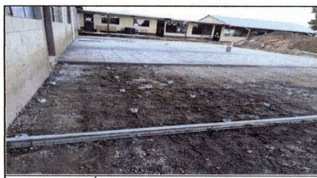
Foto 6: PREPARACIÓN TERRENO PARA CONCRETO.
