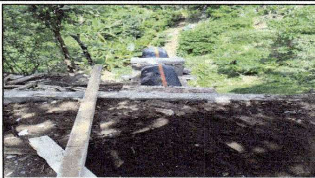
Foto 2: COLOCACIÓN DE TUBO PARA DRENAJE
