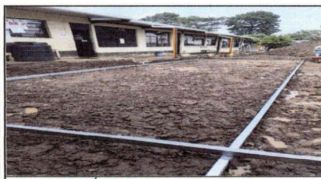
Foto 5: PREPARACIÓN TERRENO PARA CONCRETO
