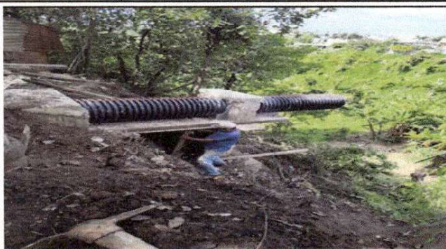
Foto1: COLOCACIÓN DE TUBO PARA DRENAJE
