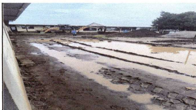
Foto 3: PREPARACIÓN TERRENO PARA CONCRETO
