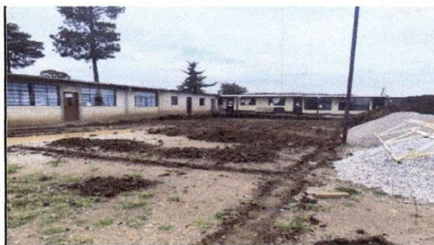
Foto 4: PREPARACIÓN TERRENO PARA CONCRETO
