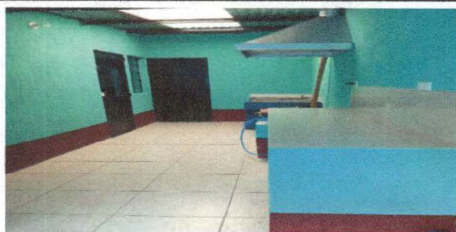
Foto 11: Reparación de cocina, cambio de piso granito por cerámico, repello en paredes, sustitución de estufa rural (completa, colocación de azulejo en pared (estufa), reparación de cableado eléctrico, pintura
