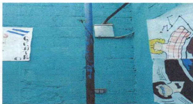
Foto 21: Reparación de caja de flipones
