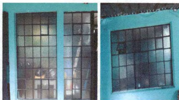
Foto 10: Sustitución de vidrios en todas las ventanas de los salones de clases
