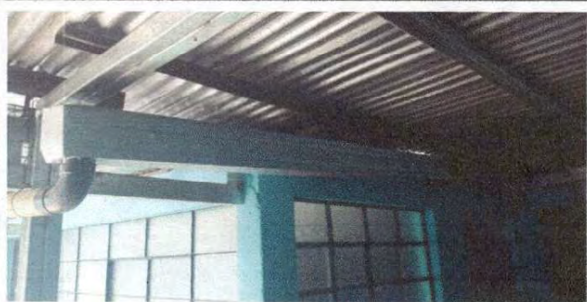
Foto 29: Sustitución de canal de metal
