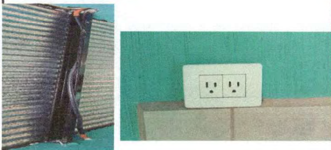
Foto 19: Mejoramiento de sistema electrico en cocina y corredor (sustitución de plafoneras, sustitución de 2 tomacorrientes dobles, sustitución de lamparas ahorradoras tipo led, sustitución de cableado)
