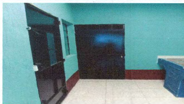
Foto 8: puertas de cocina y sanitario al fondo de la cocina
