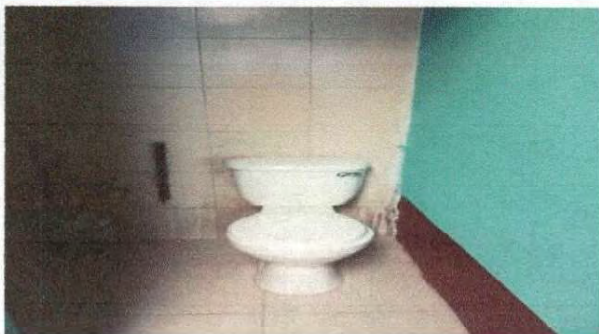
Foto 1: Sustrución de sanitario en el area superior, frente al salón de primero b
