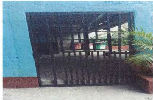
Foto 14: Mantenimiento de baranda de patio numero dos, que da al salón de segundo b y c.
