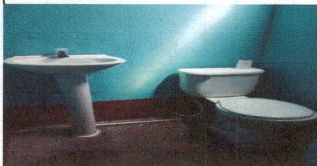
Foto 2: Sustrución de sanitario y favamanos en el area superior, frente al salón de primero b
