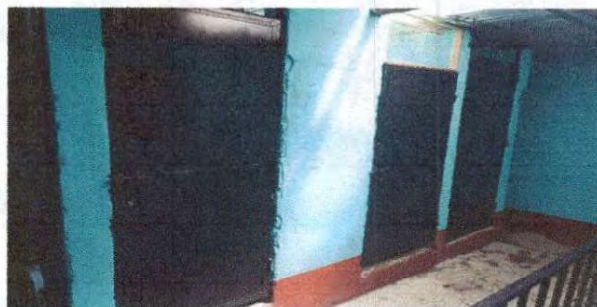
Foto 6: Sustrución de dos puertas de sanitaris, de mader a por metal en el segundo piso, frente a primero b.
