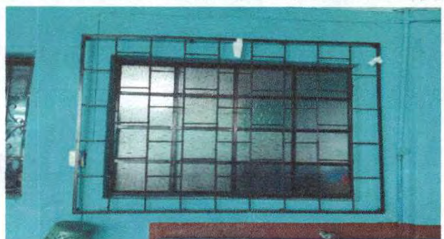
Foto 9: Sustitución de ventana salón a la par de dirección
