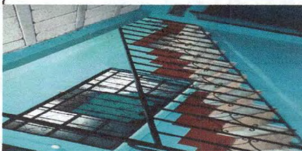
Foto 4: Reparación de baranda de hierro que da para el segundo nivel, (está podrida)
