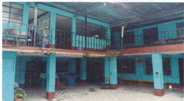
Foto 25: Pintura en todo el edificio, primer y segundo piso
