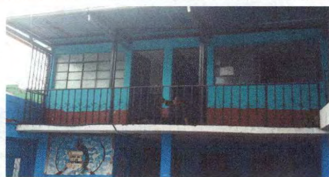
Foto 27: barandas reforzadas con tubo de metal
