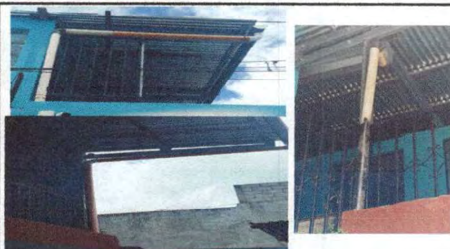
Foto 28: reparación de bajadas de agua
