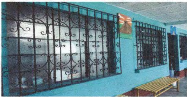
Foto 15: Mantenimiento de cinco balcones de ventanas en el primer piso.
