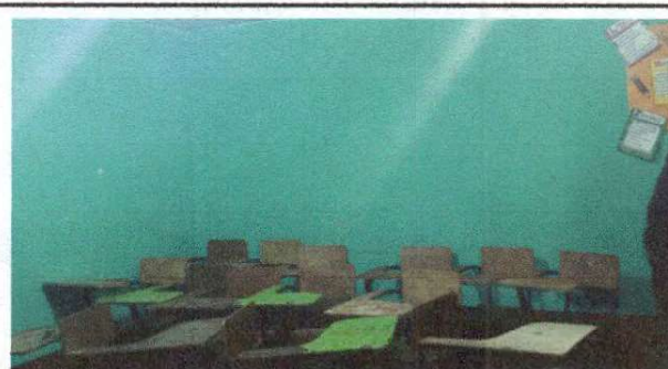
Foto 24: repello en salón a la par de dirección
