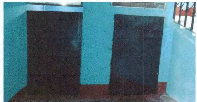
Foto 16: Mantenimiento y pintura de puertas de sanitarios de primer piso, dirección y salón de maestros.
