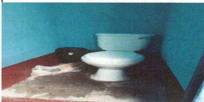
Foto 3: Sustrución de sanitario area superior frente del salón de primero b
