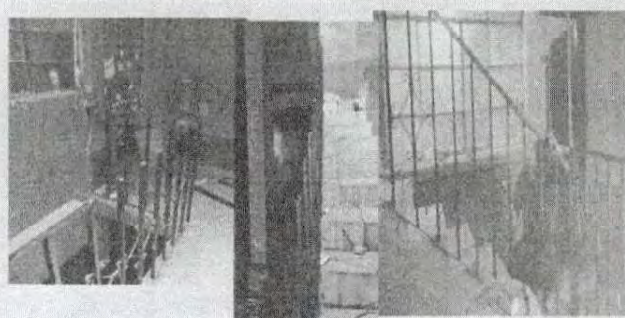
Foto 4: Reparando baranda de hierro que da para el segundo nivel, (esta podrida)
