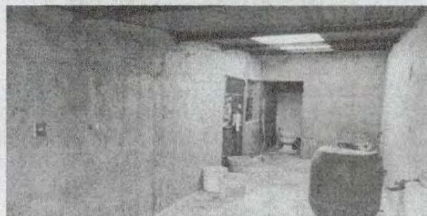
Foto 8: Desinstalando puerta de madera primer piso, fondo de la cocina.
