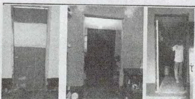
Foto 24: Sustitución de 3 puertas de madera por metal en salones de primer nivel, reparación de puerta principal.
