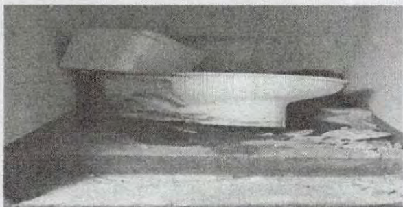
Foto 1: Levantado de sanitario en el area superior, frente al salón de primero basico sección b
