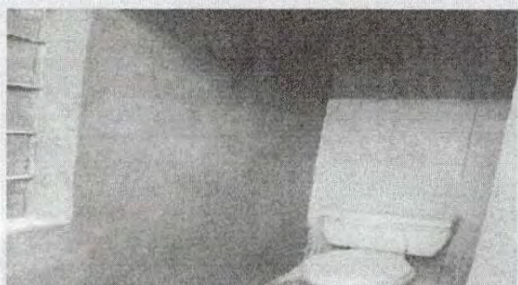
Foto 3: Levantado de sanitario en el area inferior, al fondo de la cocina
