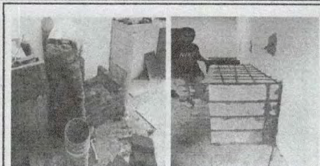
Foto 26: Sustitución de estufa rural (completa)
