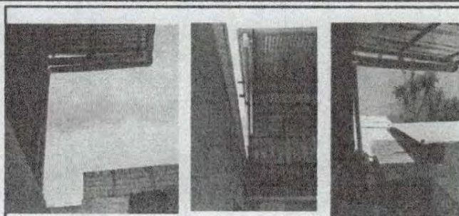
Foto 26: Reparación de bajadas de agua pluvial, tubo pvc
