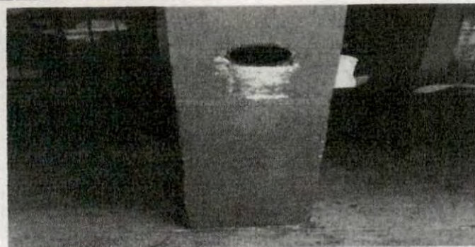
Foto 28: Reparación de dos bajadas de agua pluvial en el primer piso.
