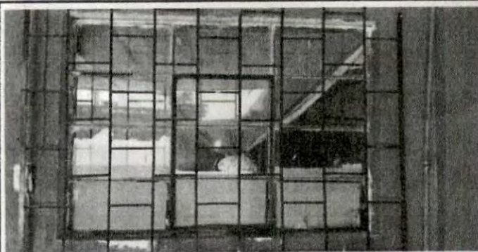
Foto 9: SUSTITUCIÓN DE VENTANA COMPLETA CON MARCO, SALÓN DE DOCENTES A LA PAR DE DIRECCIÓN.
