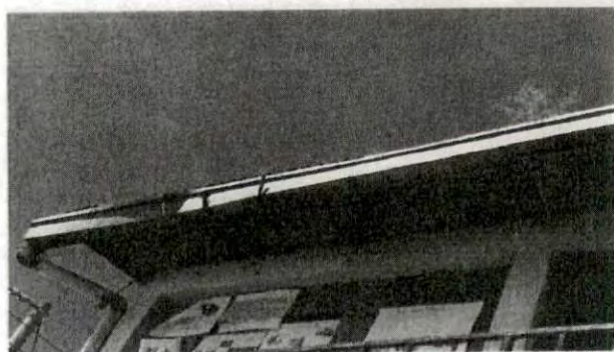
Foto 27: Pintura parte del segundo piso
