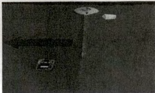
Foto 19: SUSTITUCIÓN DE PLAFONERA Y TOMACORRIENTE EN EL SALÓN DE SEGUNDO A
