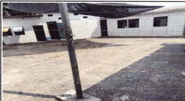
Foto 2: Area del patio que se pintara
