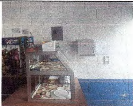
Foto 5: AREA DE TIENDA QUE SE PINTARA
