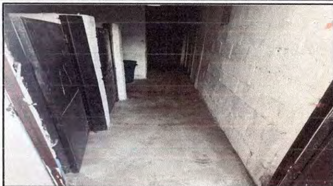
Foto 1: Entrada de baños de señoritas del INEB Telesecundaria Villas del Quetzal
