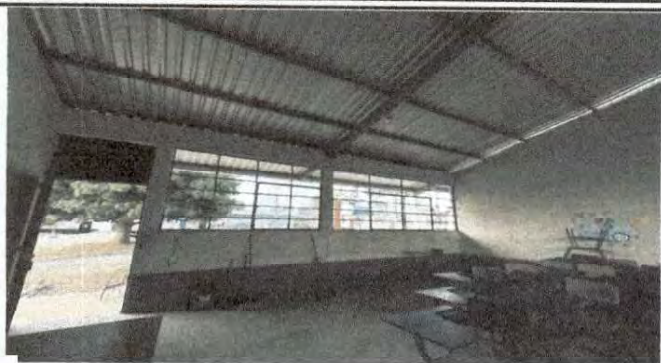
Foto 1: las nuevas ventanas de los módulos 3,4,5, 6 y 7 de las clases
