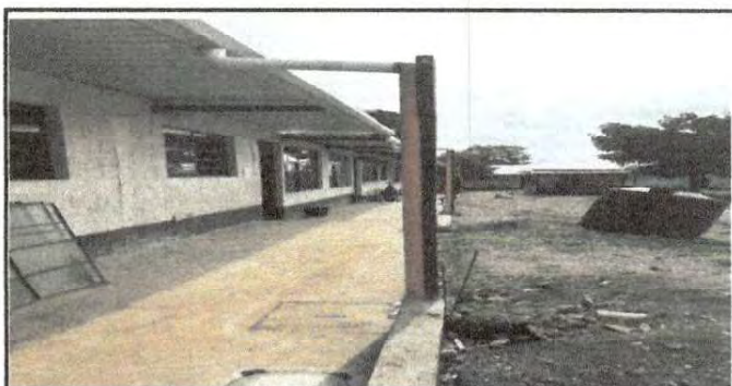
Foto 6: Terminada las pequeñas caja de agua pluvial
