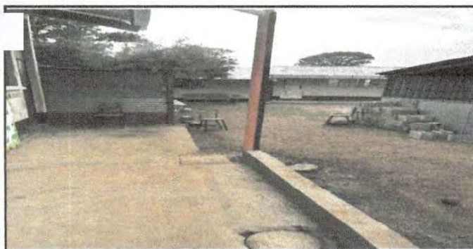
Foto 5: El canal de concreto sellado y terminado
