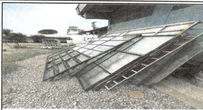
Foto 2: Las ventanas que se retiran
