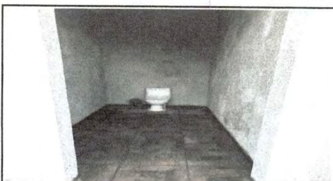
Foto 4: instalación completa del nuevo piso de los baños de preprimaria
