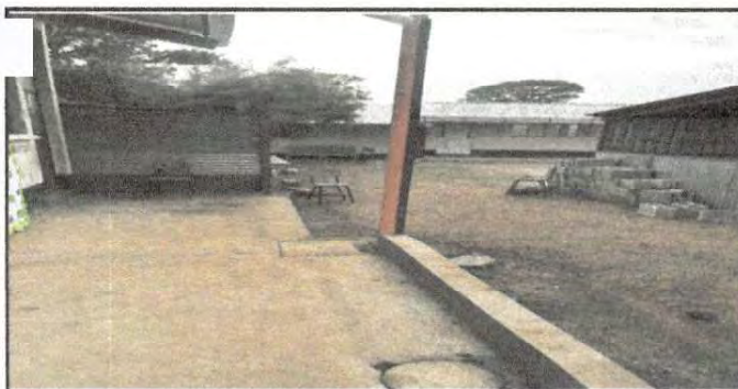
Foto 5: El canal de concreto sellado y terminado
