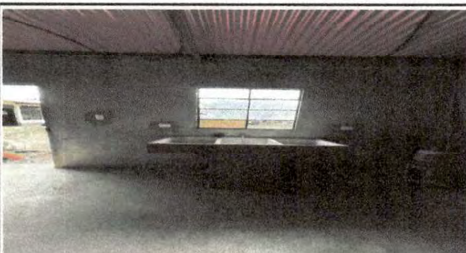
Foto 3: Instalación completa de la pila de la cocina (sobrante de remozamiento)
