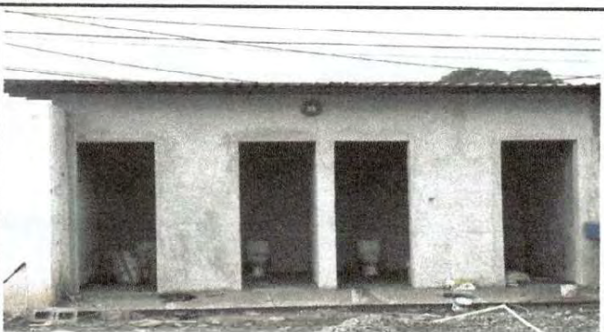
Foto 3: la instalación de los cuatro baños de preprimaria
