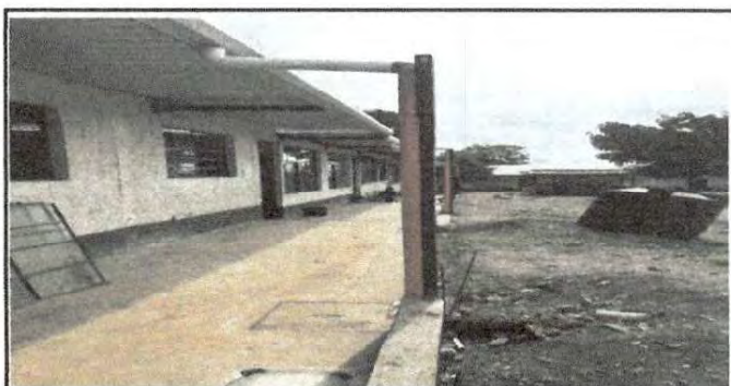
Foto 6: Terminada las pequeñas cajas de agua pluvial
