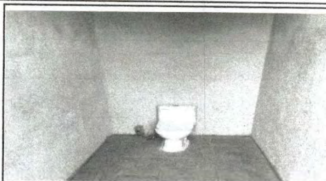
Foto 2: instalación de tubería y accesorio de los baños de preprimaria
