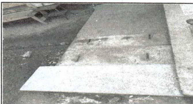
Foto 4: La bóveda o caja de agua pluvial terminada
