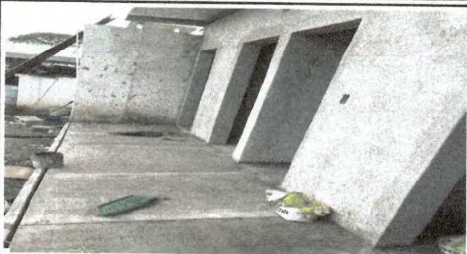
Foto 1: la baqueta terminada de los baños de preprimaria
