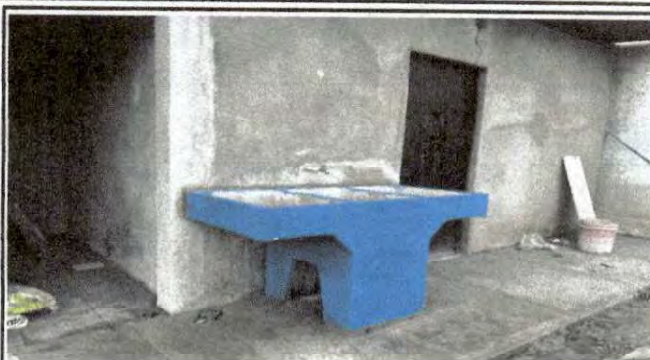
Foto 2: Instalación completa de la pila del patio (sobrante de remozamiento)
