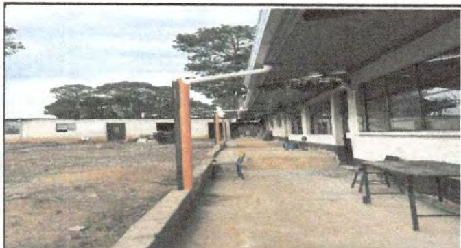
Foto 3: Instalación completa de las caídas de agua, reforzada con una costanera
