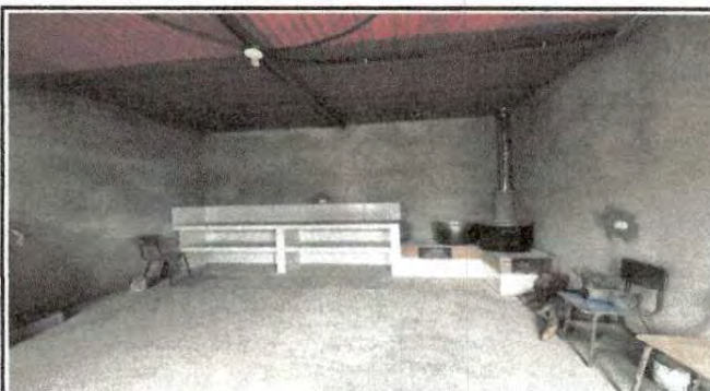
Foto 4: Terminado la mesa de concreto, polletón y chimenea de la cocina (sobrante de remozamiento)
