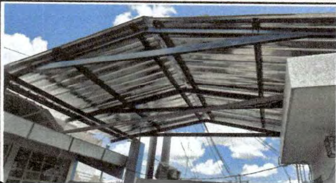
Foto 1: Instalación completa del techo del frente de la escuela (sobrante de remozamiento)
