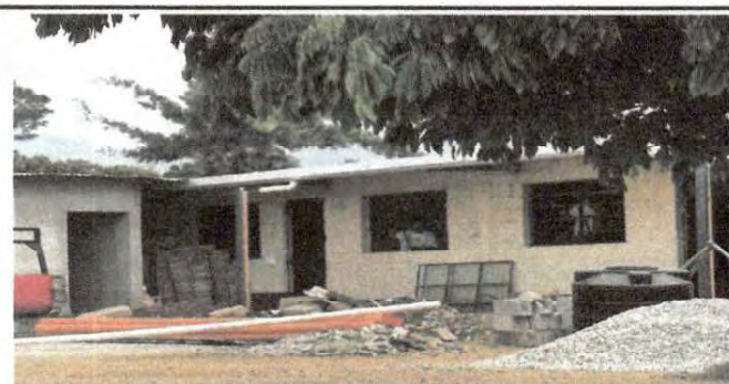
Foto 5: Quitando las ventanas antiguas
