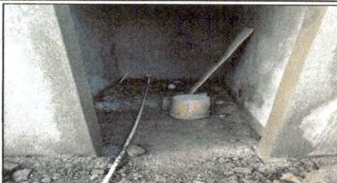
Foto 2: Tubería de los baños de preprimaria
