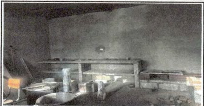
Foto 2: remozar la mesa de cemento, el polletón y la chimenea de la cocina
