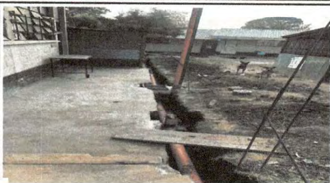
Foto 1: Zanjear y en tubar para el agua fluvial
