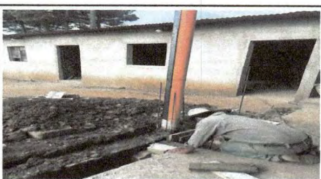
Foto 4: Colocación de la caída de agua
