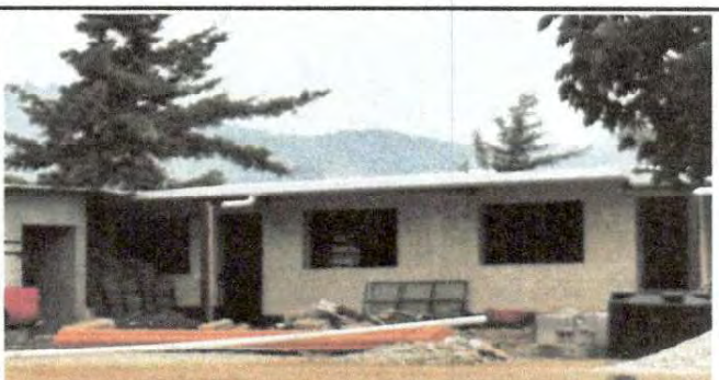
Foto 6: Colocando la ventanas nuevas
