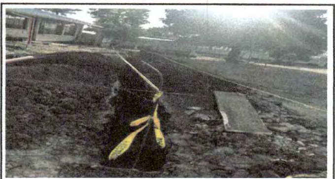
Foto 4: Inicio para el drenaje y tubería para la pila que esta dentro de la cocina
