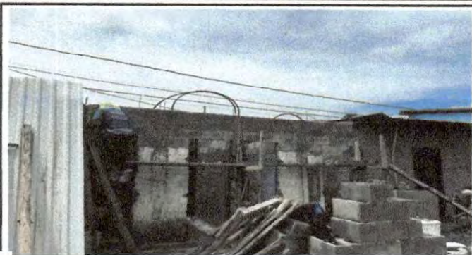
Foto 1: Elevando el nivel de la pared de los baños de preprimaria
