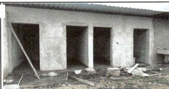
Foto 5: Repello de los baños de preprimaria
