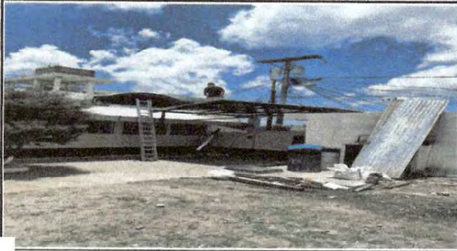
Foto 1: inicio del techado de la entrada de la escuela
