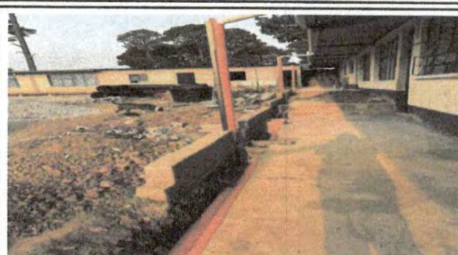
Foto 2: Conexón de la caída de agua con la tubería para aguas pluviales
