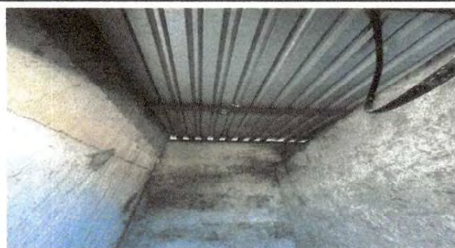
Foto 3: Cambio de la estructura metal y láminas de los baños de preprimaria
