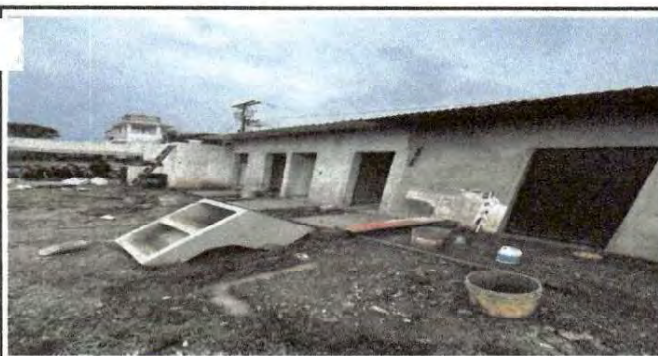
Foto 5: Retiro de la pila vieja del patio
