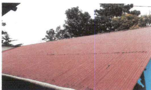
Foto 3: Mantenimiento de láminas limpieza, lijar y pintar.
