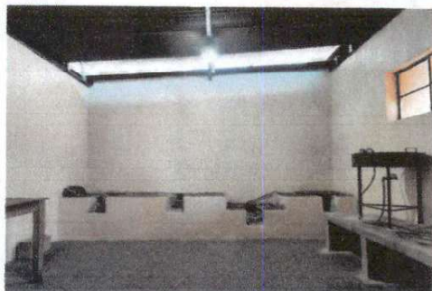
Foto 1: reparación de la estufa rural y chimeneas.
