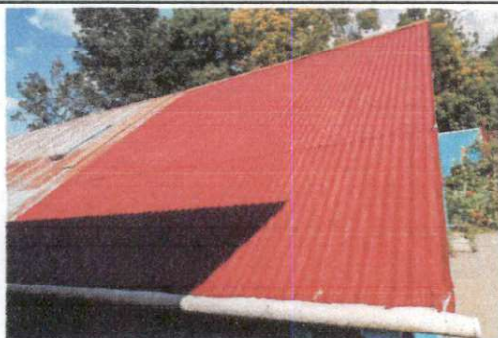
Foto 3: Mantenimiento de láminas limpieza, lijar y pintar.
