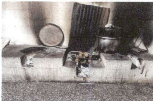
Foto 1: reparación de la estufa rural y chimeneas.
