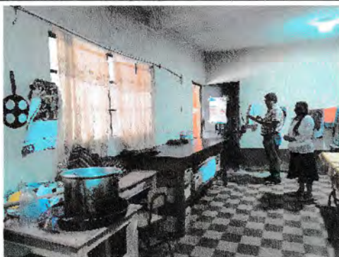
Foto 9: Presidenta de OPF indicando que la puerta esta en mal estado
