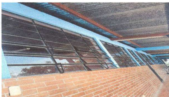
Foto 9: Sustitución de estructura de metal de ventana por ventanas corredizas de tres aulas del segundo nivel.
