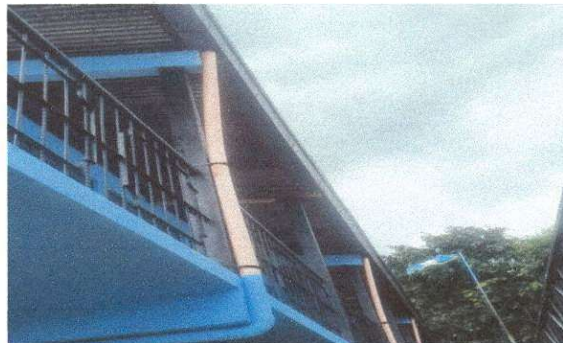
Foto 8: Reparación de canales y bajada de agua del segundo nivel
