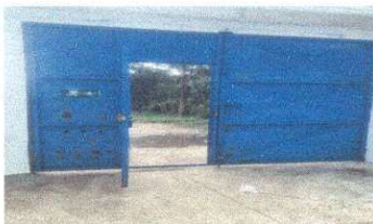
Foto 7: mantenimiento de portón de entrada a la escuela.
