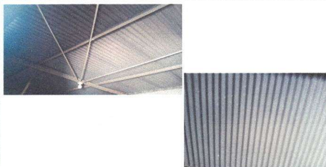
Foto 6: Sustitución de lámina del área de cocinapor lámina nueva.
