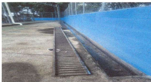
Foto 5: Fabricación de cuneta de concreto ubicada a la par de la cocina.
