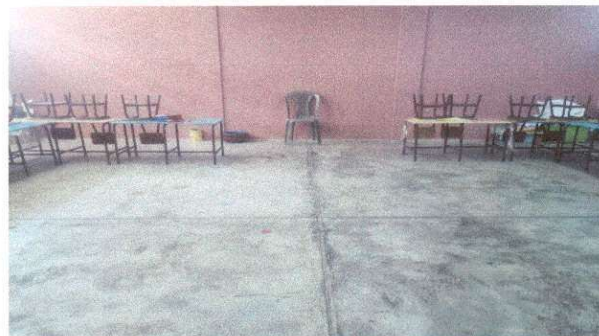
Foto 2: Colocación de piso antideslizante en torta de concreto en el salón de clases. No. 2
