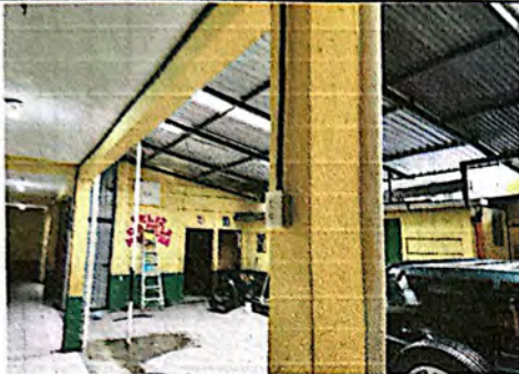
Foto 7: Suministro de nuevos tomacorrientes incluyendo tubería + cajas rectangulares + cableado.
