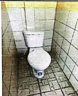
Foto 9: Suministro e instalación de inodoro.
