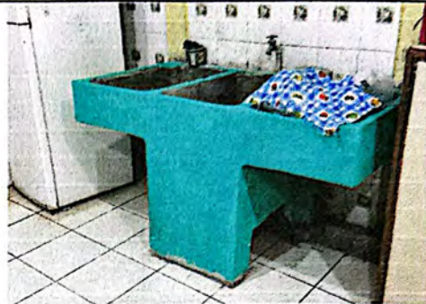
Foto 8: Suministro e instalación de pila en cocina.
