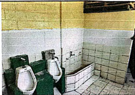
Foto 10: Suministro e instalación de azulejo complementario.
