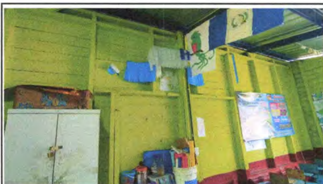
Foto 9: Interior de Aula
