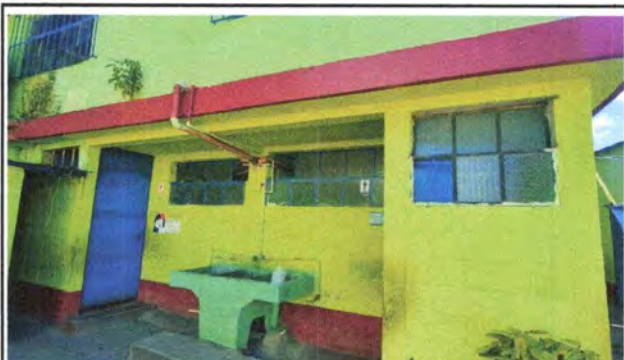
Foto 3: Pila y modulo de baños
