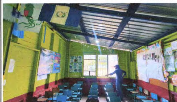
Foto 8: Interior de Aula
