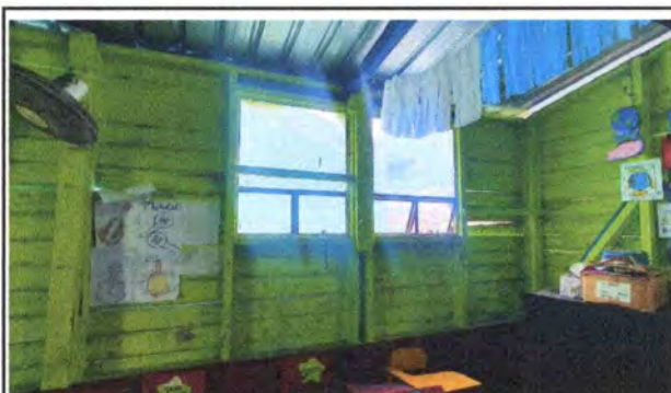
Foto 10: Interior de Aula
