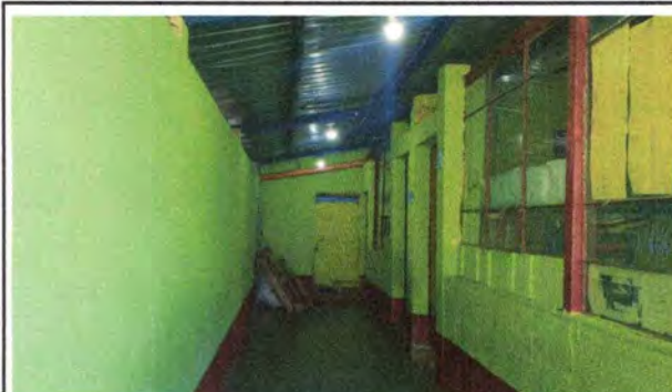
Foto 2: Pasillo modulo de aulas
