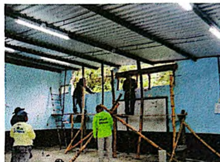
Foro 8: Apertura y refuerzo para ventana en salón
