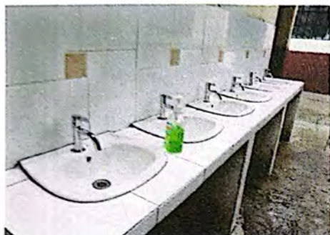
Foto 7: Suministro e instalación de grifería en lavamanos
