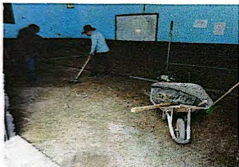
Foto 3: Trabajo de preparación de la base para cotrapiso.
