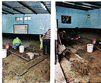
Foto 4: Fundición de contrapiso en salón.
