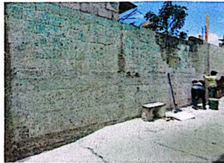
Foto 10: Aplicación de Monocapa en muro colindante
