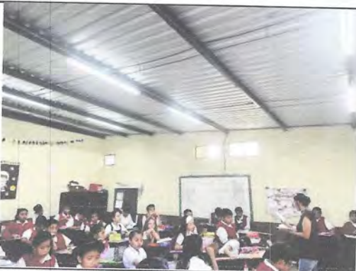
Foto 3: No se cuenta con ventanería apropiada para la iluminación y ventilación del salón de clases
