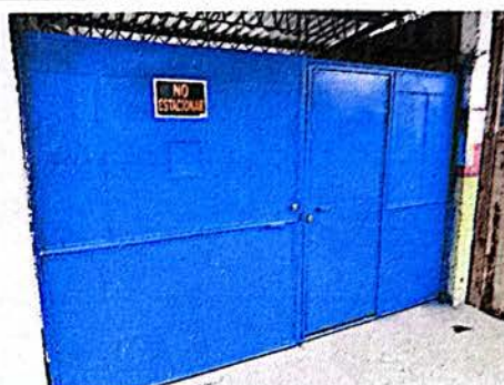
Foto 2: Mantenimiento de portón.
