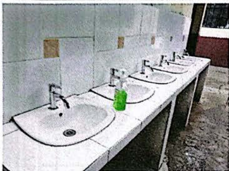
Foto 7: Suministro e instalación de grifería en lavamanos + Cambio de drenaje tipo sifón.
