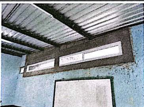
Foto 3: Apertura de vano en salón de clases + suministro e instalación de ventana UPVC.
