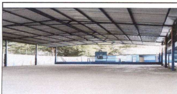
foto 3: Se aprecia solidificación del 3er. día posterior a la fundición de losa.
