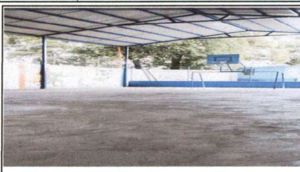
foto 2: Losa recientemente fundida con elevación de 5 cms. y electro malla.
