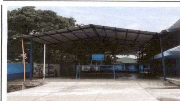
foto 5: Imagen completa del trabajo de techado y mejoramiento de pavimento de cancha finalizados
