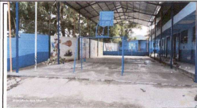
foto 1: Últimos detalles de fundición de losa. se puede apreciar que se encuentra aun sin solidificar.
