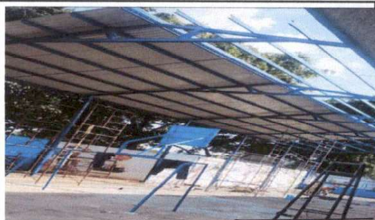
foto 6: Colocación de lámina calibre 26 en estructura de techado.
