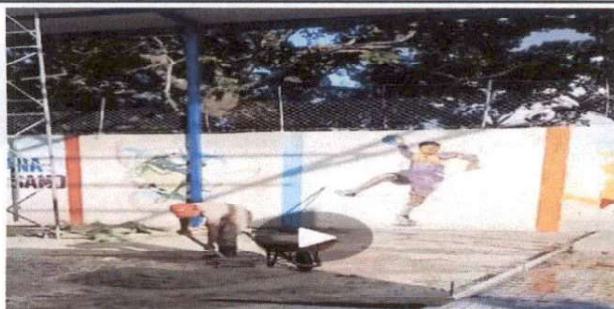
foto 3: fundición de loza de 5 cms. con electromalla para eliminar irregularidades en el pavimento de cancha que ocasionan accidentes en el alumnado
