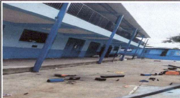
foto 2: Colocación y cimentación de postes para techo.
