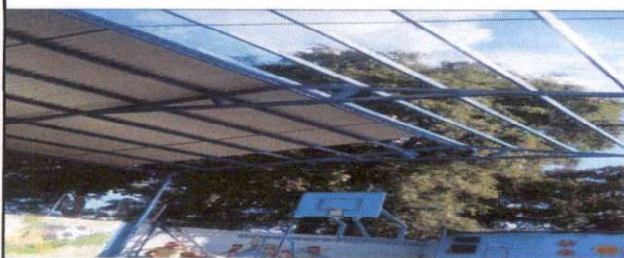
foto 5: Colocación de tubos para armar los postes y tijeras para la estructura del techo.
