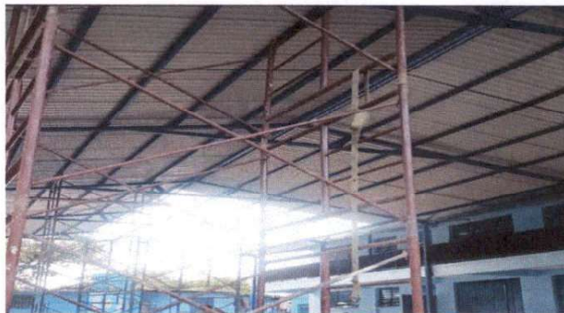
foto 4: Colocación de láminas calibre 26 para techado de cancha.
