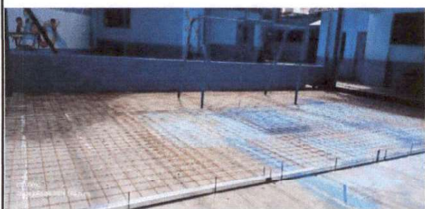
foto 1: Colocación de electromalla para mejoramiento de pavimento de cancha.
