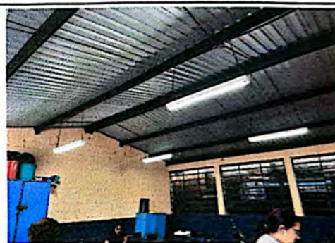
Foto 4: Suministro e instalación de lámparas en salones módulo C, mejorando de manera considerable la iluminación.
