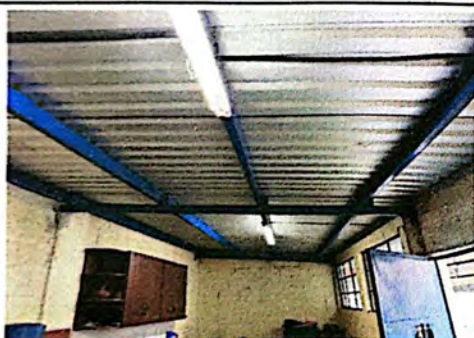
Foto 9: Suministro e instalación de estructura metálica para techo en cocina.
