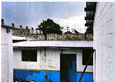
Foto 7: Vista interior de cocina, con estructura metálica de soporte + lámina troquelada + red de iluminación y fuerza.
