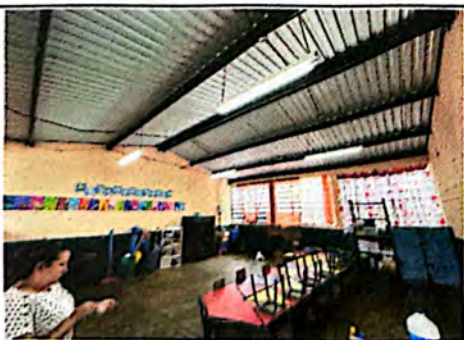
Foto 5: Cambio en el sistema eléctrico salones módulo B, incluyendo iluminación y fuerza.
