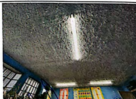
Foto 6: Instalación de luminarias en dirección, incluye lámpara, cableado e interruptor.
