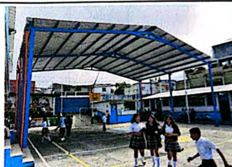
Foto 10: Instalación de estructura de soporte y lámina troquelada en cancha de juegos.
