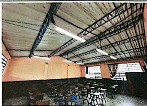
Foto 1: Suministro e instalación de sistema eléctrico, incluye cableado y lámparas módulo A segundo nivel
