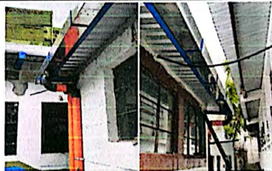
Foto 10: Suministro e instalación de canal y tubería para descarga pluvial.
