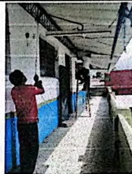
Foto 2: Suministro e instalación de cableado eléctrico.
