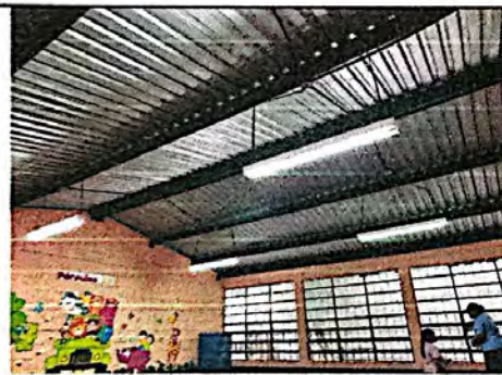
Foto 3: Instalación de lámparas para iluminación de salones.
