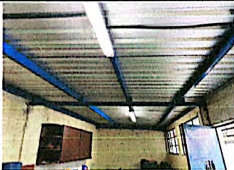
Foto 9: Vista interior de cocina, con estructura metálica de soporte + lámina troquelada + red de iluminación y fuerza.
