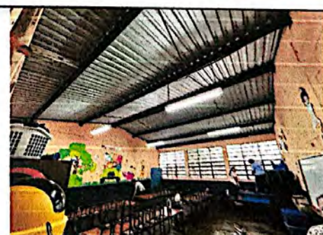
Foto 6: Vista general de salón de clase con nueva red eléctrica para la iluminación.
