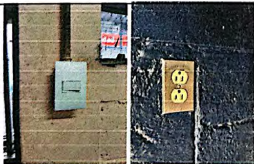
Foto 5: Suministro e instalación de interruptores y tomacorrientes con placa de acero inoxidable.
