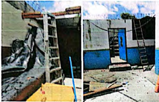
Foto 7: Desmonte de Techo en área de cocina.
