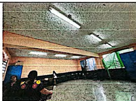
Foto 4: Suministro e instalación de lámparas en salones, mejorando de manera considerable la iluminación.
