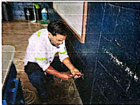
Foto 1: Suministro e instalación de cableado eléctrico.
