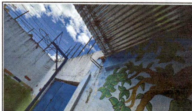
Foto 4: MEJORAMIENTO DE MURO Y TECHO EN PATIO.
