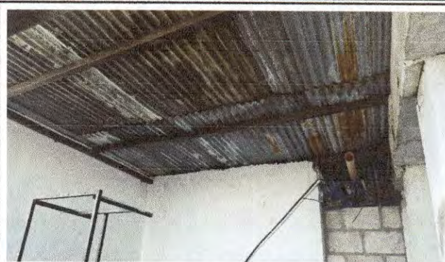
Foto 8: SUMINISTRO E INSTALACION DE LAMINA TROQUELADA
