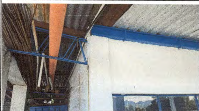
Foto 9: CAMBIO DE LAMINA PARA TECHO Y CON ESTREUCTURA METALICA
