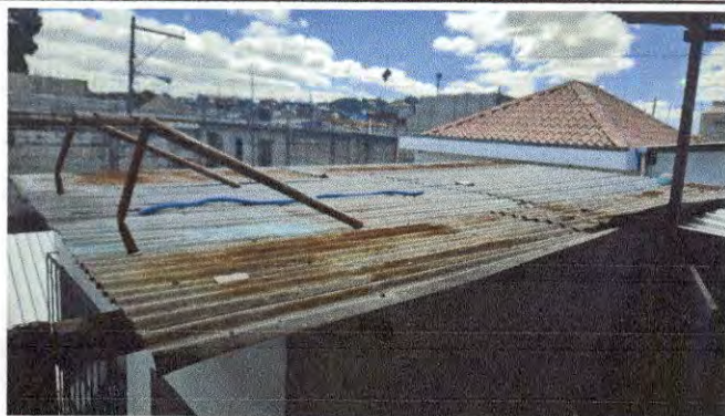
Foto 7: . REMOZAMIENTO DE LAMINA EN COCINA EN DETERIORO.
