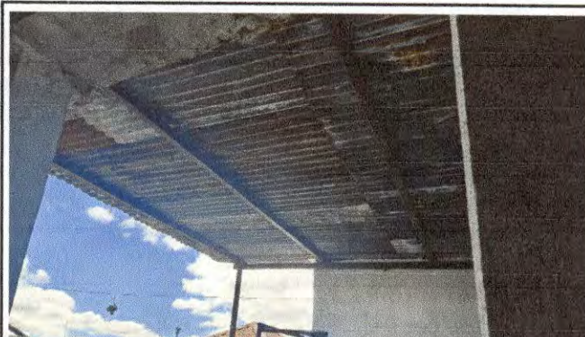
Foto 10: SUMINISTRO E INSTALACION DE ESTRUCTURA METALICA Y LAMINA TROQUELADA.
