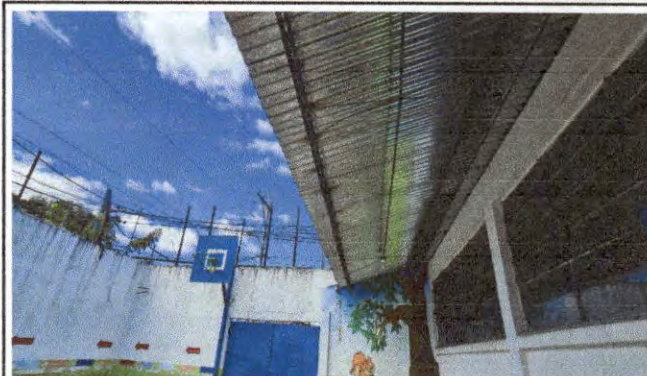
Foto 2: AMPLIACION DE SUMINISTRO E INSTALACION DE TECHO CON ESTRUCTURA METALICA.
