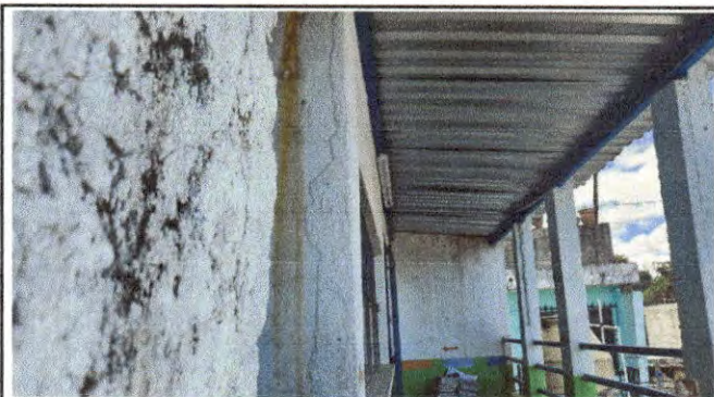
Foto 5: MEJORAMIENTO DE TECHO Y SUMINISTRO E INSTALACION DE LAMINA
