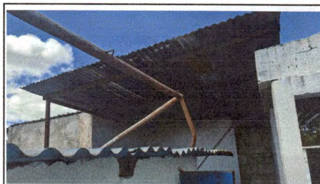
Foto 6: REMOZAMIENTO DE TECHO DE LAMINA TROQUELADA Y ESTRUCTURA METALICA.
