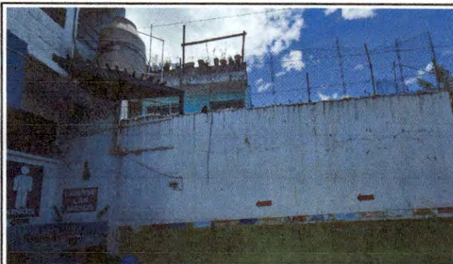
Foto 3: MEJORAMIENTO DE MURO
