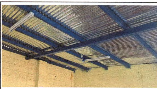
Foto 6: SUMINISTRO Y COLOCACION DE INSTALACION ELECTRICA ILUMINACION.
