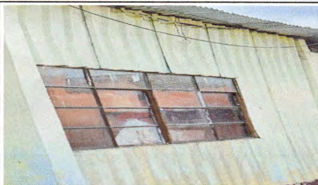
Foto 7: SUMINISTRO Y COLOCACION DE VENTANA DE PVC
