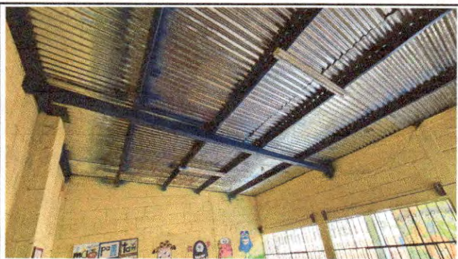
Foto 5: SUMINISTRO Y COLOCACION DE INSTALACION ELECTRICA FUERZA.
