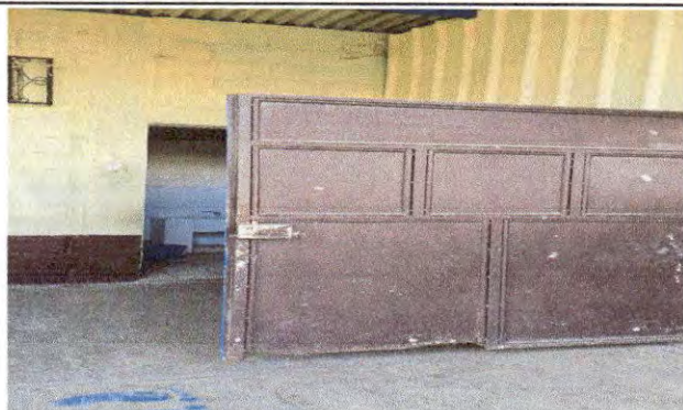
Foto 3: COLOCACION Y SUMINISTRO DE PUERTA DE METAL
