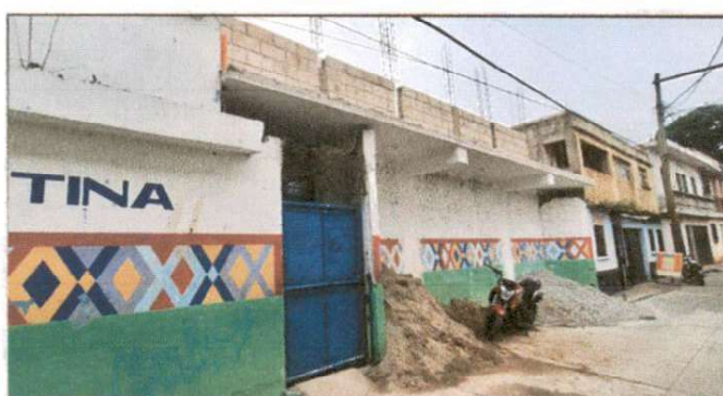
Foto 6: Frente de la ampliación de la terraza terminada e inicio de construcción de la nueva aula para construcción de una nueva
