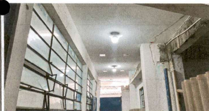
Foto 5: Remozamiento del sistema de iluminación del pasillo fuera del aula
