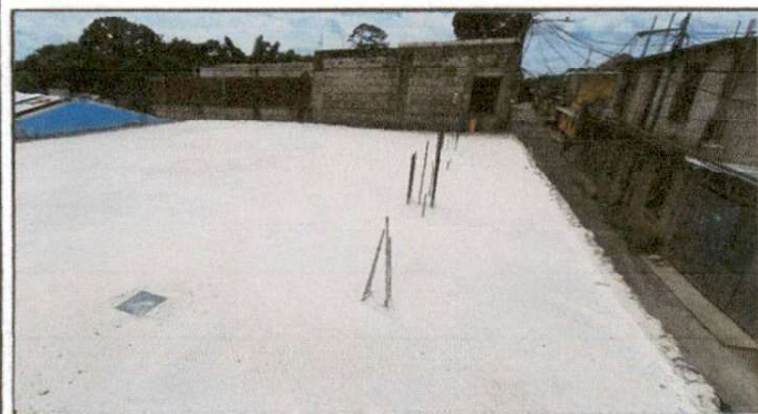
Foto 3: Ampliación de terraza terminada
