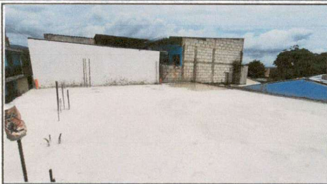
Foto 2: Ampliación de terraza terminada
