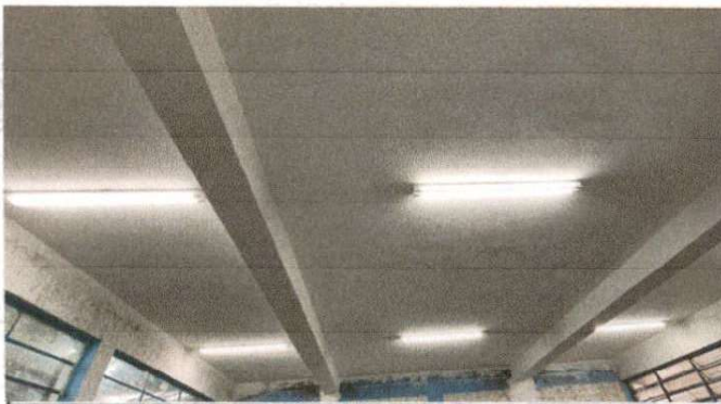
Foto 4: Remozamiento del sistema de iluminación dentro del aula
