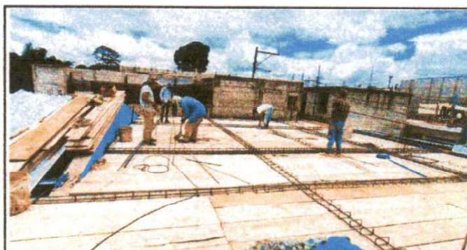
Foto 6: Elaboración y colocación de armadura de la ampliación de terraza
