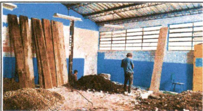
Foto 3: Cavado para fundición de zapatas de las columnas que sostendrán la ampliación de terraza
