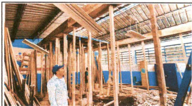
Foto 4: Montaje de andamiaje para posterior ampliación de la terraza
