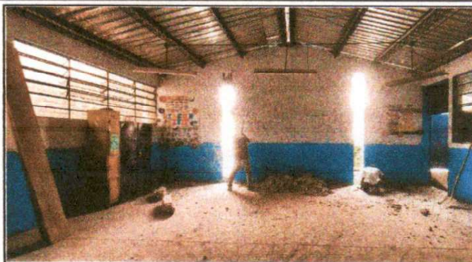
Foto 2: Área de la escuela en proceso de remodelación
