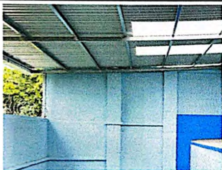
Foto 3: Levantado de muro en parte posterior de patio de juegos, para evitar generar daños al muro colindante.
