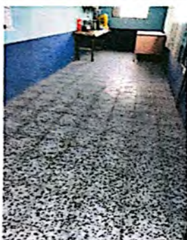
Foto 9: Suministro e instalación de piso granito en dirección.
