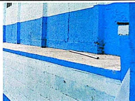
Foto 4: Fundición de torta de cemento.
