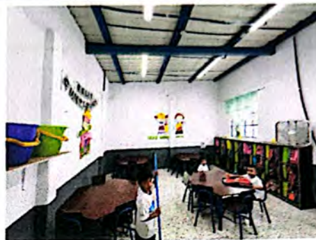
Foto 8: Aplicación de pintura en muros interiores del salón de preprimaria.
