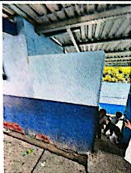
Foto 1: Levantado de 2 hiladas de block + repello y pintura
