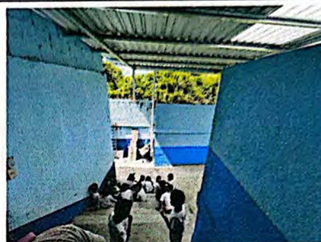
Foto 2: Suministro e instalación de techo.
