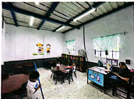
Foto 7: Suministro y aplicación de pintura en salón de clases.
