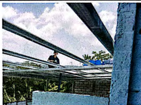
Foto 2: Instalación de estructura de soporte para techo.
