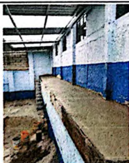
Foto 5: Fundición de torta de concreto.
