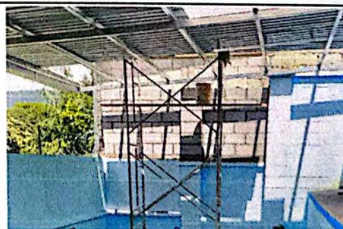
Foto 6: Levantado de muro en pared colindante.
