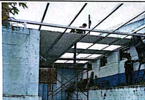
Foto 3: Colocación de lámina troquelada.
