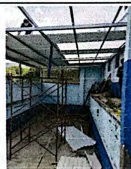
Foto 4: Instalación de lámina troquelada.
