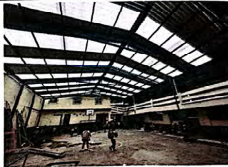
Foto 8: Suministro e instalación de estructura de soporte para techo + lámina
