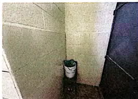
Foto 4: Colocación de Azulejo baño de niñas.
