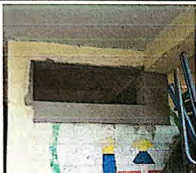
Foto 1: Apertura de vano para ventilación en baño.
