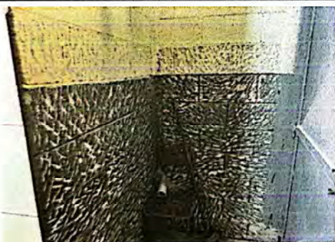
Foto 3: Preparación de muro para colocación de azulejo.
