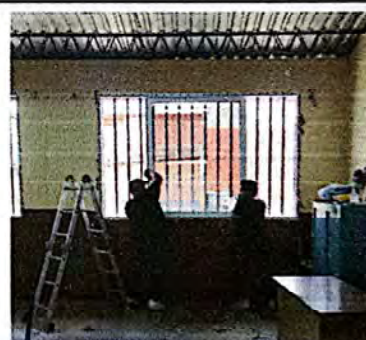
Foto 10: Suministro e instalación de ventanería UPVC.
