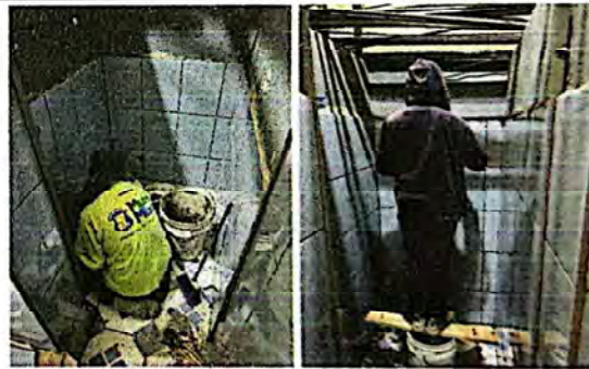
Foto 4: Colocación de Azulejo.
