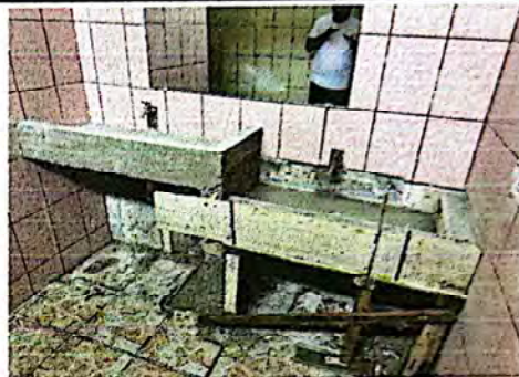
Foto 2: Fabricación de pileta en baño de niñas.
