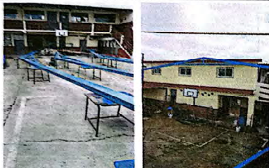
Foto 7: Fabricación de tijeras para techo + instalación de las mismas.
