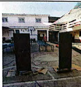
Foto 6: Mantenimiento a puertas metálicas de baños.
