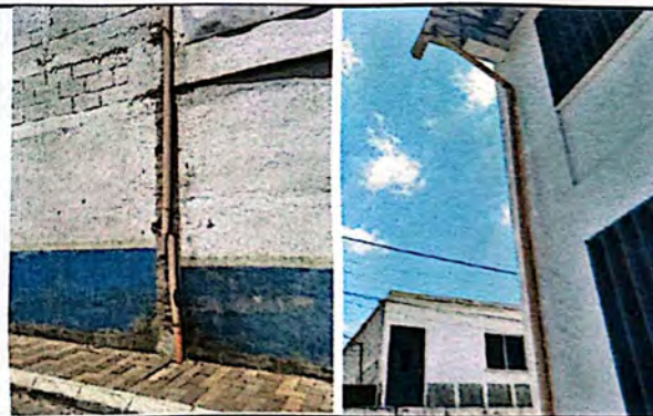
Foto 10: Bajadas de agua pluvial dañadas por el sol y con falta de sujeción a los muros lo que genera la ruptura de las mismas por el movimiento.
