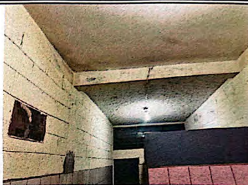
Foto 8: Coincide la mancha de humedad en el muro que colinda con servicio sanitario de hombres por lo que refuerza la teoría de fuga en tubería empotrada en pared.
