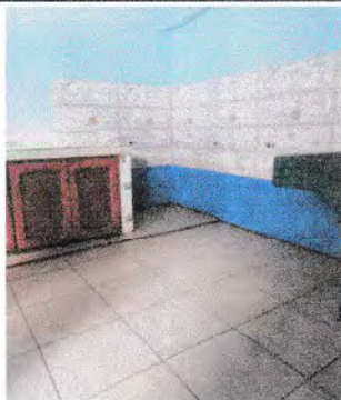
Foto 3: Cocina pintada y piso colocado.
