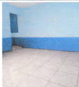
Foto 4: Bodega pintada y piso colocado.
