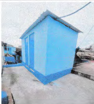
Foto1: Módulo de 02 sanitarios.
