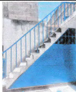
Foto 12: Pintura de baranda de escalera.
