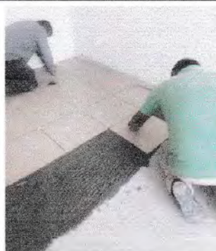
Foto 2: Colocación de piso en salón de maestros.
