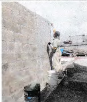
Foto1: Levantado de módulo de sanitarios.
