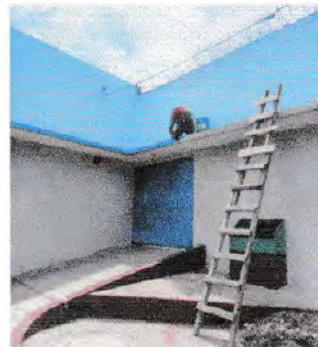
Foto 8: Pintando exterior de la escuela.
