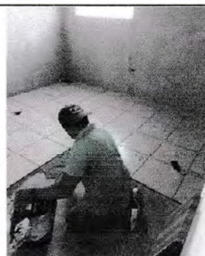
Foto 4: Colocación de piso en bodega.
