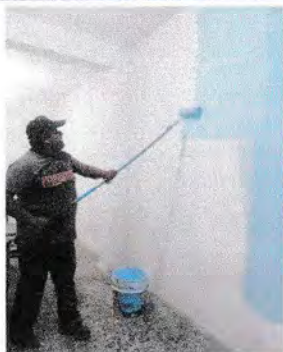
Foto 7: Pintando interior del aula.
