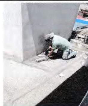
Foto 6: Colocación de pañuelos en terraza.
