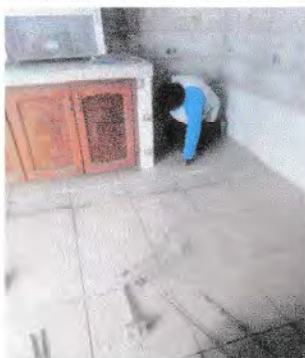
Foto 3: Colocación de piso en cocina.
