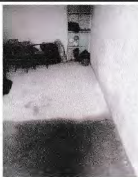
Foto 5: Torta de concreto en salón de Educación Física, sin piso.
