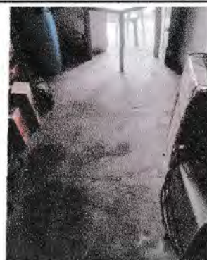
Foto 2: Torta de concreto en salón de maestros, sin piso.
