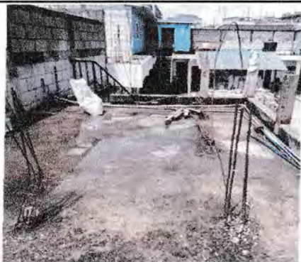
Foto 1: Espacio destinado para módulo de 02 sanitarios.
