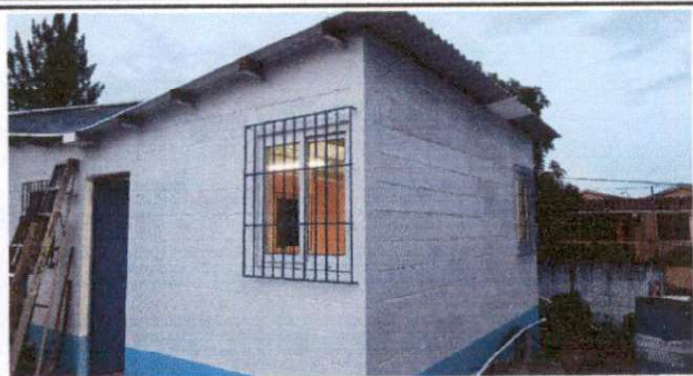
SUMINISTRO E INSTALACION DE MUROS DE BLOCK
