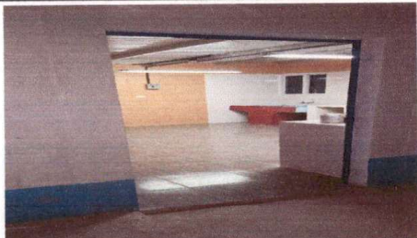
SUMINISTRO Y CAMBIO DE PISO
