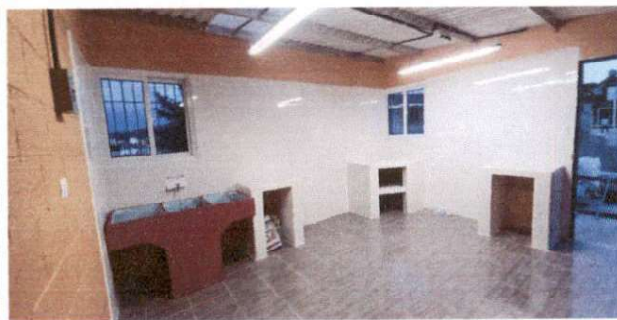
SUMINISTRO E INSTALACION DE TECHO
