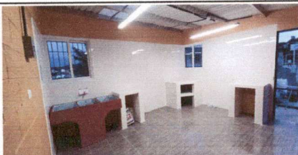
INSTALACION DE MESON DE COCINA
