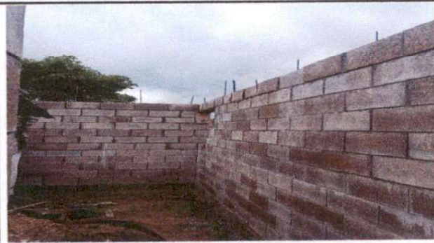
SUMINISTRO E INSTALACION DE MUROS DE BLOCK
