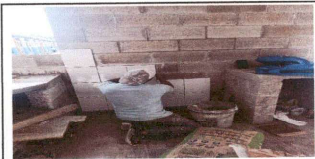
INSTALACION DE MESON DE COCINA
