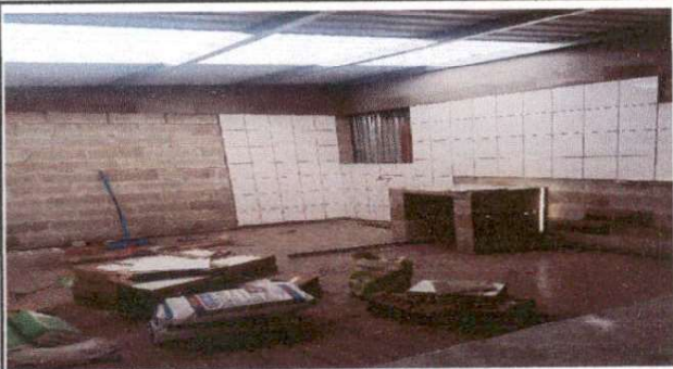
SUMINISTRO Y CAMBIO DE PISO
