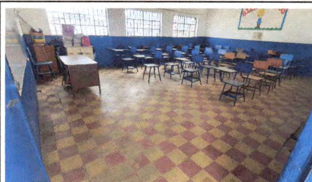
Foto 8: Interior de Aula
