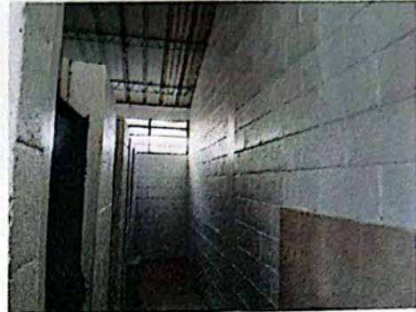
Foto 2: Aplicación de pintura en muros interiores.
