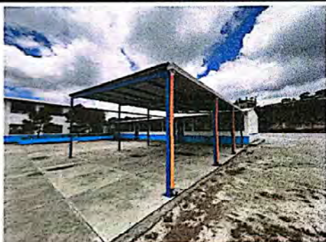
Foto 9: Suministro e instalación de estructura para techo.
