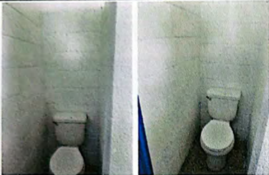
Foto 1: Suministro e instalación de inodoros + pintura.
