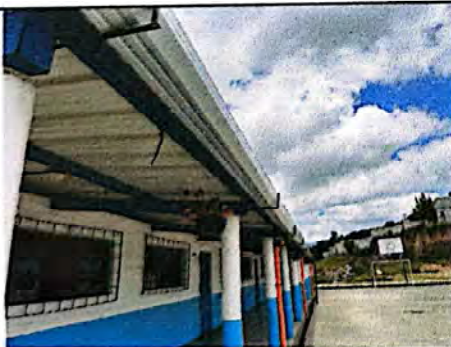
Foto 5: Suministro e instalación de canal pluvial.
