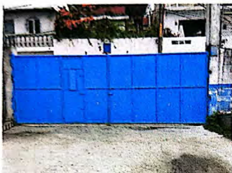
Foto 7: Mantenimiento de portón en ingreso principal.
