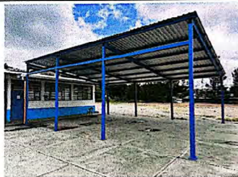
Foto 10: Armado de estructura para ampliación de techo con instalación de lámina troquelada calibre 25.
