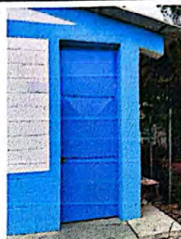
Foto 2: Mantenimiento a puerta de cocina actual, incluye lijado y pintura
