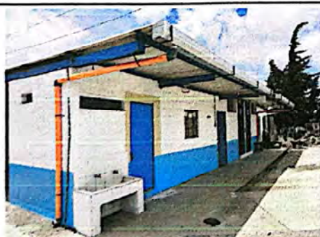
Foto 5: Aplicación de pintura en Módulo.
