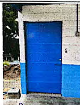
Foto 6: Mantenimiento de puerta, incluye, lijado y pintura.
