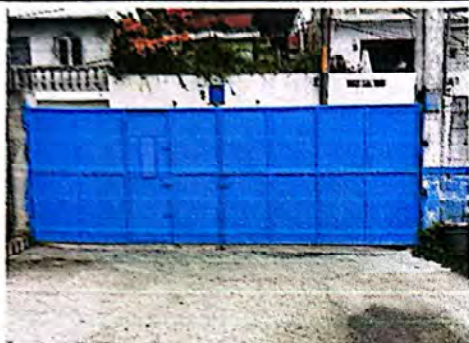
Foto 1: Mantenimiento de Portón, incluye lijado y pintura.
