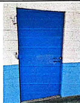
Foto 4: Mantenimiento de puertas en salones de clases
