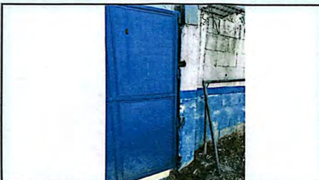
Foto 3: Los anclajes del portón en las columnas representan un peligro, tomando en cuenta el tamaño del mismo y que estos se encuentran expuestos.
