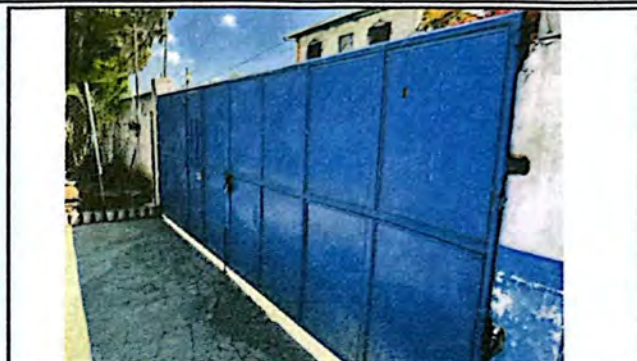
Foto 2: Se deberá realizar el mantenimiento al portón de ingreso, poniendo especial énfasis en el anclaje con las columnas tomando en cuenta que se ha desprendido en repetidas ocasiones.
