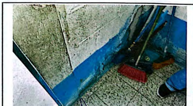
Foto 6: Se muestra el deterioro en la pintura, específicamente del Módulo B tomando en cuenta que es el que mas se frecuenta por la existencia de los servicios sanitarios.
