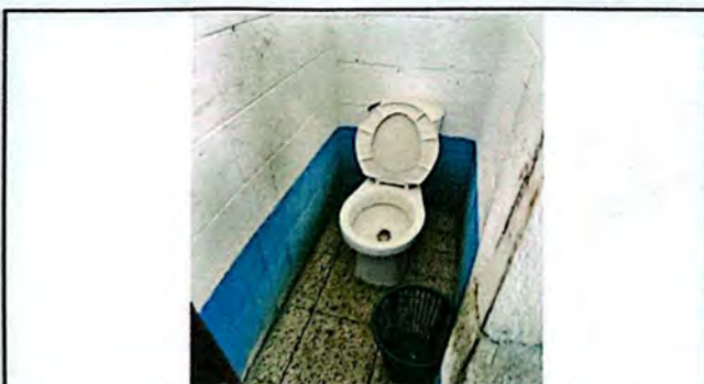
Foto 5: Los inodoros presentan problemas en los accesorios internos y todos se encuentran con la tapadera del tanque quebrada.
