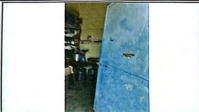
Foto 1: . Estado actual de Puerta en cocina Módulo A, muestra deterioro por lo que se debe realizar el mantenimiento correspondiente.
