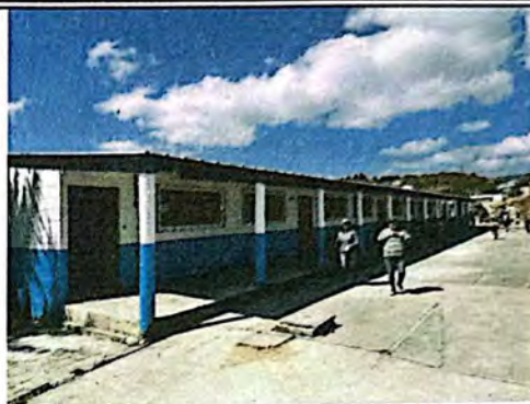
Foto 8: El módulo C no cuenta con canales pluviales, ni bajadas de agua.
